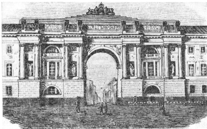
ПЕТЕРБУРГ. ЗДАНИЕ СЕНАТА И СИНОДА
