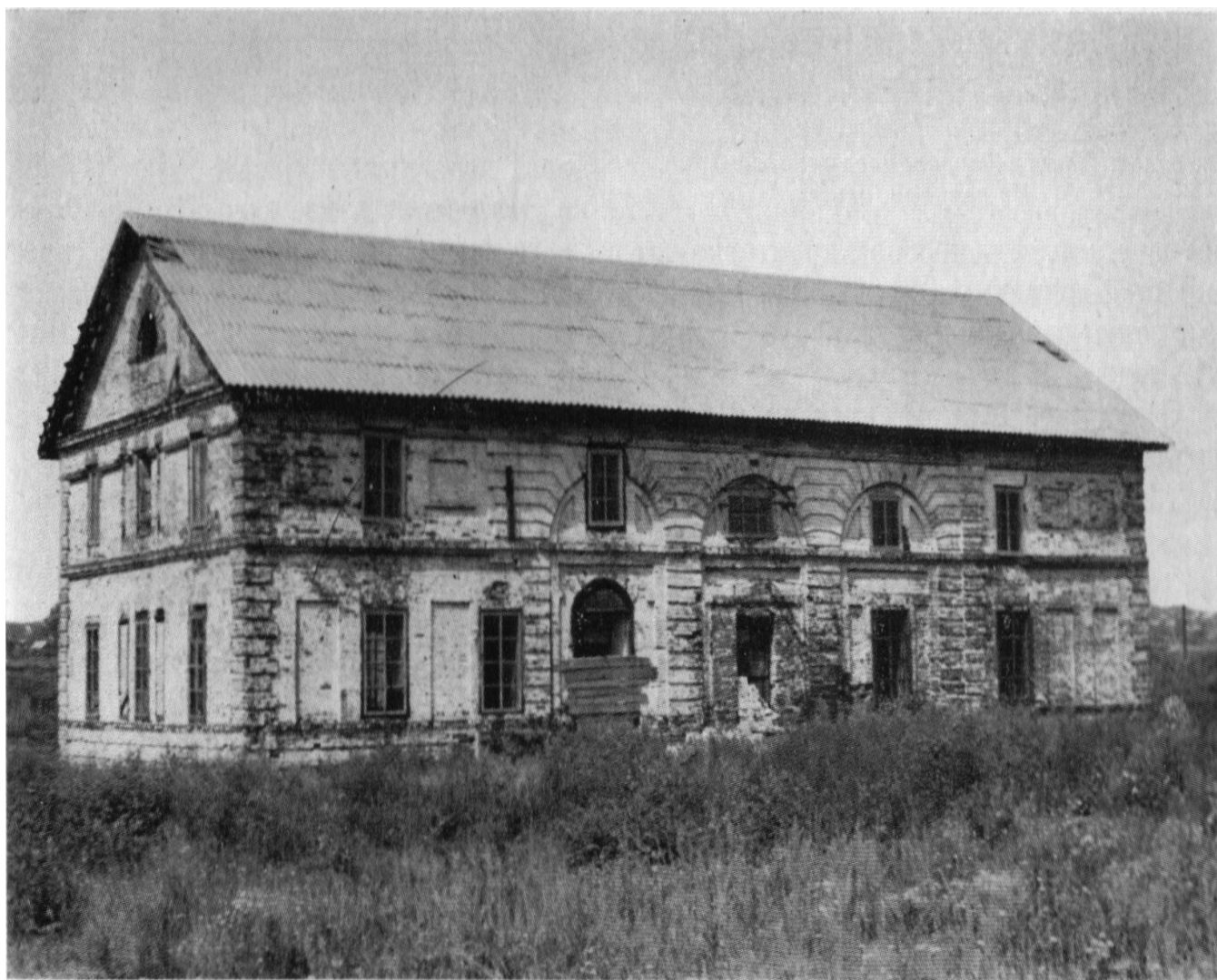
Усолье. Каменный соляной амбар. Боковой фасад
