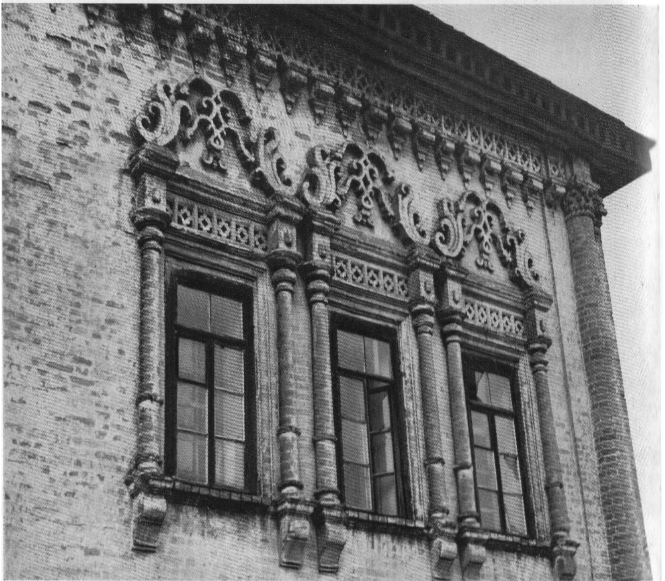
Усолье. Палаты Строгановых. Наличники окон фасада со стороны Камы
