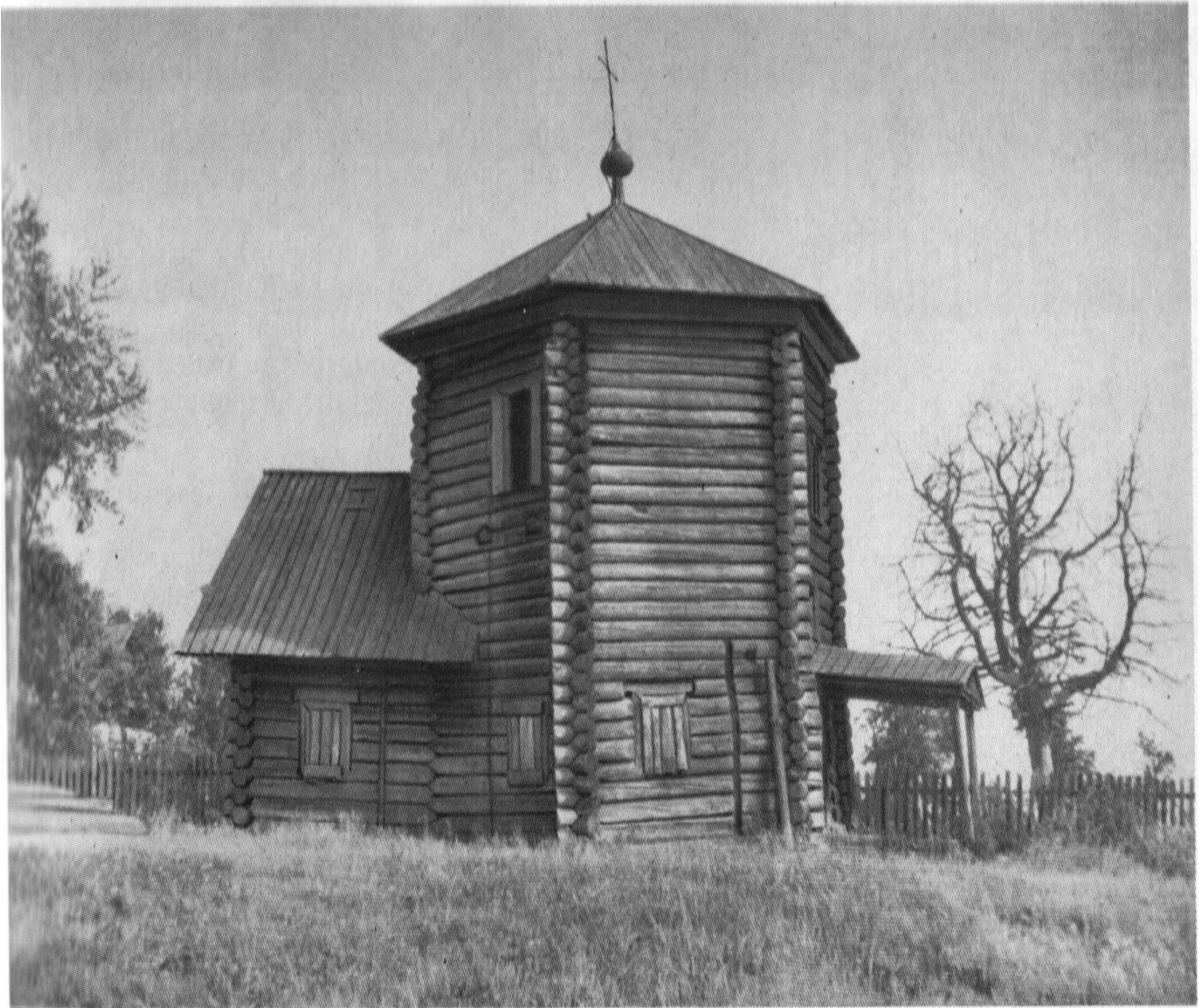
Пянтег. Церковь Богоявления. Вид с севера
