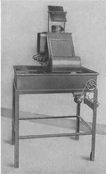
Abb. 23. Wasserwanne mit Episkop zur Projektion von Strömungsbildern.
