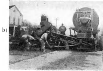
Abb. 166 a und b. Entleerung des Mixers an der Rückseite in einen auf einem Ausleger schwenkbaren Küber [C 45].
