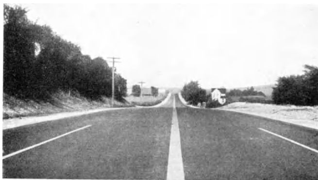
Abb. 199. Erstklassige Überlandstraße zwischen Akron und Canton in Ohio mit Klinkerdecke auf bewehrter Betonunterlage, Breite 12 m, Länge 35 km, hergestellt 1929/30 [C 136].
