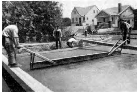
Abb. 174. Herstellung einer Längsfuge auf 5 bis 7 cm Tiefe mittels eines T-Eisens [D 54].
