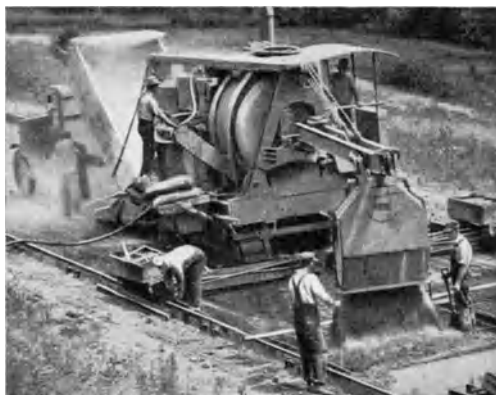
Abb. 154. Betonmischer mit Abgleichbohle in Tätigkeit [D 47].
