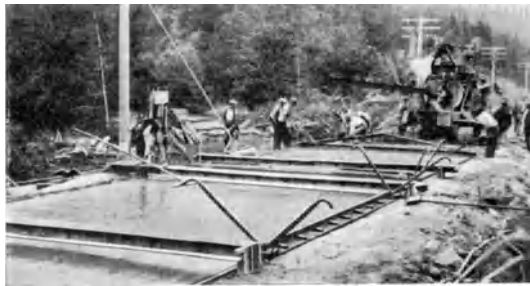
Abb. 164. Herstellung einer Betondecke im Handbetrieb, u. a. Ersatz der Stampfbohle durch eine leichte Walze [D 56].
