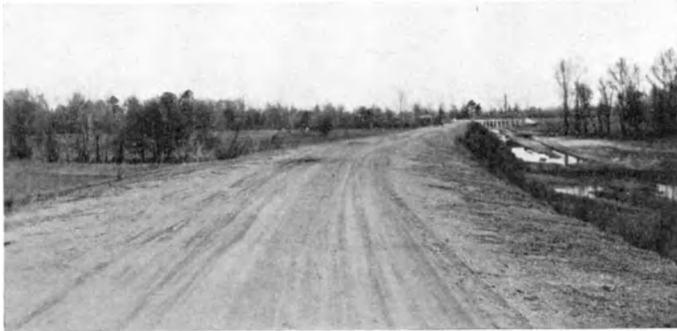
Abb. 67. Tonsandstraße (Topsoilstraße) aus Nord Karolina [E 8].
