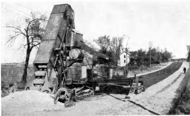
Abb. 84. Fahrbare Mischanlage (travelling mixer) für Maschinenvermischungen [C 19].
