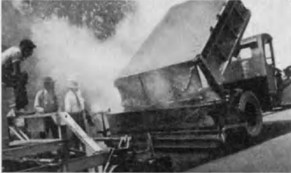
Abb. 107. Verteilung des Mischgutes mit Hilfe der Verteilertasche, welcher der Straßenfertiger unmittelbar folgt [C 152].
