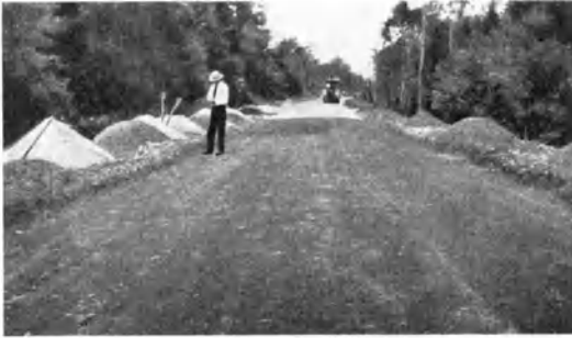
Abb. 124. Materiallagerung für den Einbau von Asphaltmakadam, alte Straßendecke vorbereitet [D 15].
