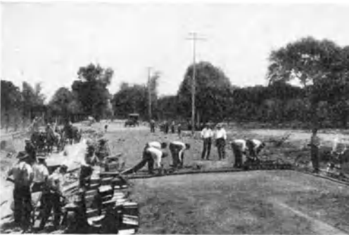
Abb. 189. Herstellung einer Klinkerdecke unmittelbar auf dem sandigen Untergrund in Florida [D 98].
