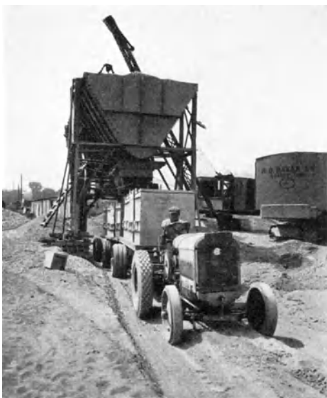
Abb. 147. Silo und Transportwagen mit einzelnen Gefäßen (Blaw-Knox Comp., Pittsburgh).
