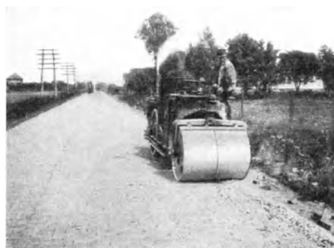
Abb. 194. Einwalzen eines Schotterstreifens als seitliche Abgrenzung einer Klinkerdecke [D 98].
