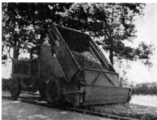
Abb. 105. Vorrichtung zum Verteilen von bituminiertem Gestein auf der Straße [D 36].
