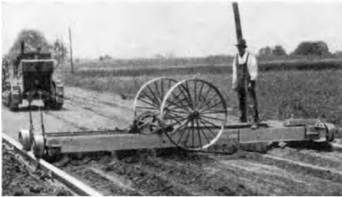
Abb. 140. Gezogener Kratzer zur profilgerechten Herstellung des Planums für eine Betondecke [D 40].
