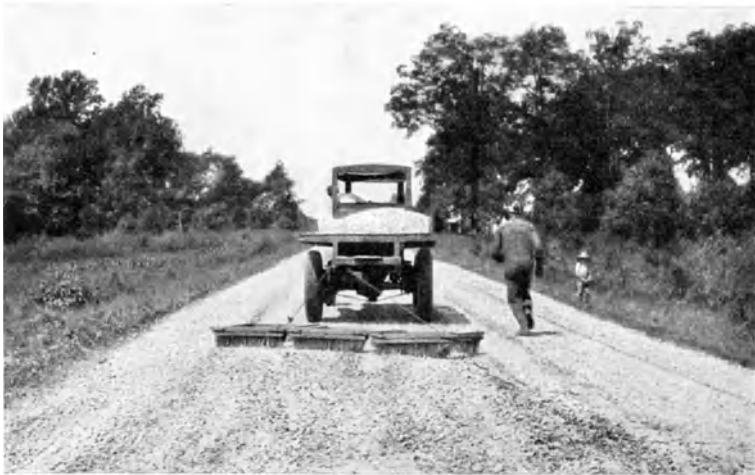
Abb. 78. Glätter mit Drahtbesen (wire-broom drag) bei der Arbeit [E 8].
