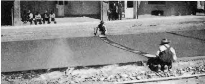
Abb. 161. Abziehen der Schlämpe mittels eines breiten Gurtes [D 58].
