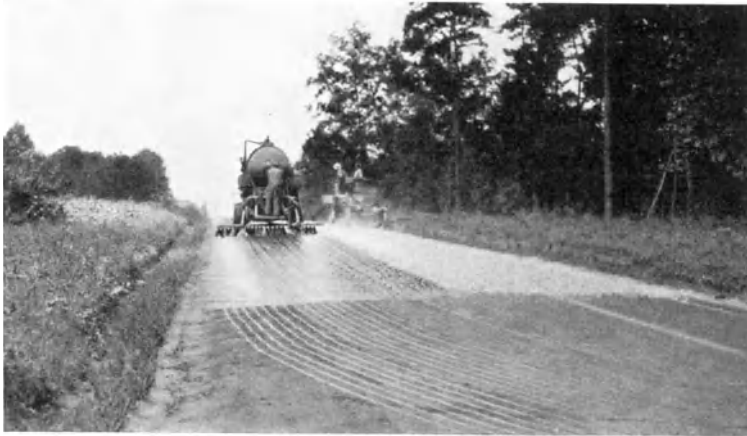
Abb. 76. Drucksprengwagen (pressure distributor) bei der Arbeit [E 8].
