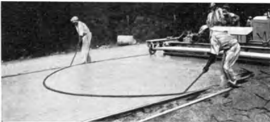
Abb. 162. Abziehen der Schlämpe mittels eines Gummischlauches [D 56].
