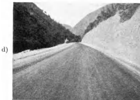
Abb. 80. Oberflächenvermischung einer Kleinschlagdecke in den Weststaaten [C 79]. c) fertige Decke, 1 Tag nach endgültiger Profilierung, d) fertige Decke nach einmonatiger Verdichtung durch den Verkehr.
