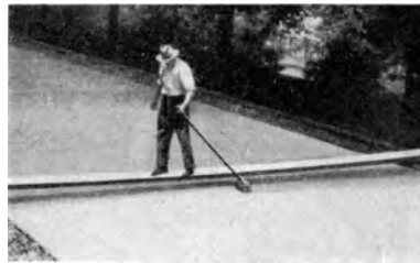
Abb. 165. Aufrauhung der Oberfläche der Betondecke mittels Besen [D 56].
