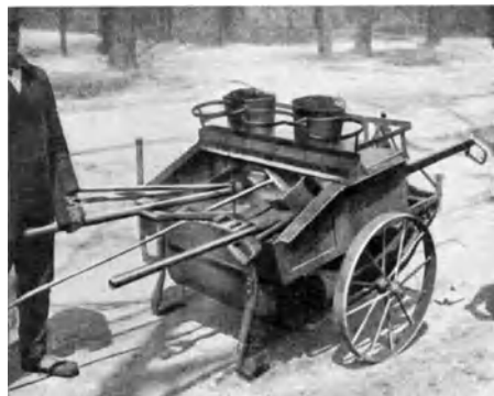
Abb. 88. Wagen zur Anwärmung von Handgeräten mit Ölfeuerung [D 4a].
