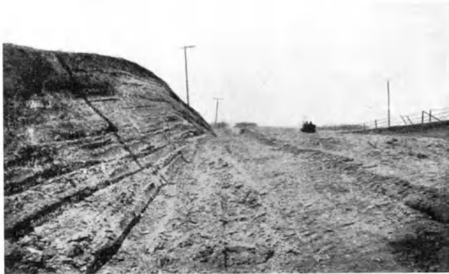
Abb. 53. Bodenfördermaschine mit Gurtband (elevating grader) für Traktorenzug der Firma J. D. Adams Comp., Indianapolis, Ind. d) Bei der Arbeit [D 1], e) Ansicht eines Einschnittes, der durch eine Bodenfördermaschine mit Gurtband in 3 Tagen bei 2600 cbm Förderung hergestellt wurde [D 65].
