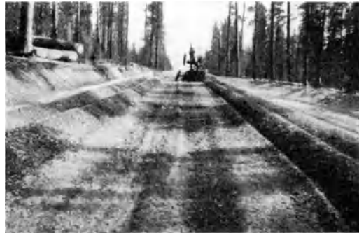
Abb. 72. Bearbeitung des Mineralgemisches einer Kleinschlagdecke mit der Planiermaschine [C 79].
