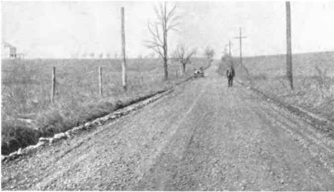
Abb. 73. Kleinschlagstraße (Township-Straße) aus New Jersey [C 155].
