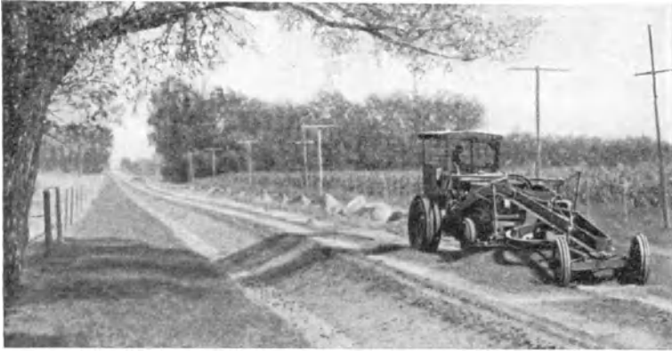
Abb. 69. Herstellung einer Kiesdecke in Kansas [D 38].
