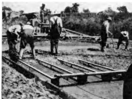
Abb. 170. Einbau der Eisenbewehrung in Betondecken mit Hilfe der sogenannten Schlitten in Gestalt von a) Rohren, b) T-Eisen, c) dünnen Profileisen, welche hin und wieder durch schwache Eisenstäbe verbunden sind [C 106].
