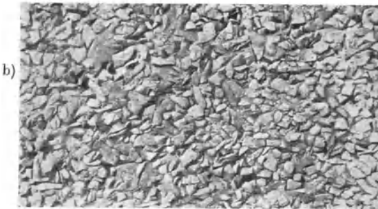
Abb. 126. Tränkmakadam. a) obere Gesteinslage aufgebracht, b) Aufsicht auf die obere Gesteinslage vor dem Abwalzen.
