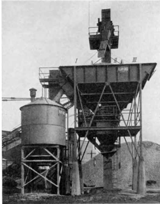
Abb. 145. Dreiteiliger Silo für die mineralischen Zuschlagstoffe, daneben Zementsilo, darunter Wiegevorrichtung und Entleerungstrichter (Blaw-Knox Comp., Pittsburgh).
