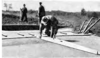
Abb. 163. Untersuchung der fertigen Beton- decke mit dem Richtscheit [D 56].
