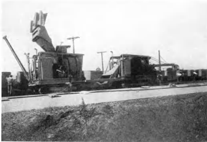
Abb. 156. Zwei Betonmischer hintereinander geschaltet, Tandemanordnung [C 124].
