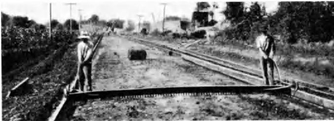
Abb. 143. Mit Nägeln versehene Lehre zur Nachprüfung des genauen Profils des Planums für eine Betondecke [D 56].
