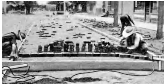
Abb. 197. Neuverlegung einer 30 Jahre alten Klinkerdecke unter Umdrehung der Klinker auf die Rückseite (90% der Klinker konnten wieder verwendet werden) [D 50].
