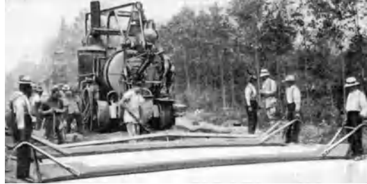
Abb. 158. Abstreich- und Stampfbohle für Handarbeit. Die Stampfbohle wird zuerst an der einen Seite angehoben und fallen gelassen unter langsamem Vorschieben auf etwa 30 cm Länge. Das gleiche geschieht alsdann auf der anderen Seite [D 56].
