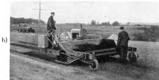
Abb. 83. Verteiler (spreader finisher) mit Rührwerk zur Verhinderung des Zusammenbackens von Gemischen aus Mineral und Bitumen und mit beweglichen Abstreifern der Firma Adnun Engineering and Manufacturing Comp. [C 112]. a) Füllung des Verteilers, b) Ausbreiten des Mischgutes.
