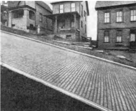
Abb. 185. Klinkerdecke mit breiten Fugen auf einer Steilstrecke 1:5 in Altoona-Pa. [D 52].
