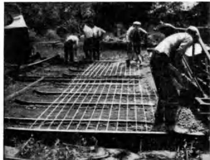
Abb. 169. Bewehrung durch Längseisen, Unterstützung derselben durch ein Quereisen, welches in seiner Lage durch Bügel und Nägel festgehalten wird [A 53b].
