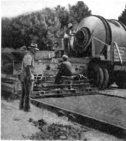
Abb. 167. Seitliche Entleerung des Mixers unmittelbar in den Verteiler [C 45].
