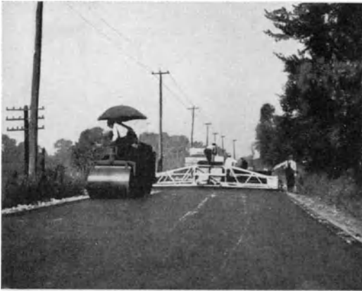
Abb. 108. Straßenfertiger und Straßenwalze in unmittelbarer Folge bei der Arbeit, Ansicht von hinten [C 152].
