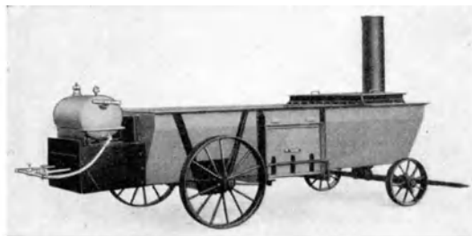
Abb. 114. Wärmewagen für Aufbruchmassen mit Ölfuehrung [D 45].
