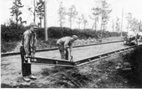
Abb. 139. Verlegen von Randschienen für Betondecken [F 11].
