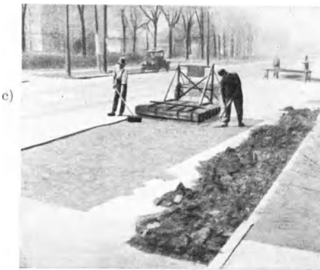
Abb. 113. Fahrbare Wärmeplatte zum Erwärmen und Erweichen von Bitumendecken. a) während der Beförderung, b) gebrauchsfertig, c) im Betrieb [D 34].
