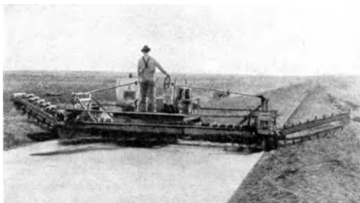
Abb. 178. Aufbringen von Boden mittels Bagger zur Feuchthaltung einer Betondecke [A 39].
