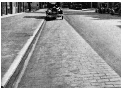
Abb. 183. Seitlicher Klinkerstreifen, Standspurbreite [D 49].
