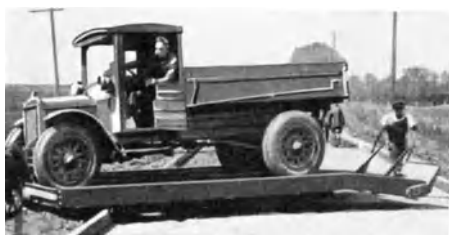
Abb. 148. Einfache Drehscheibe für Lastkraftwagen auf der Baustelle [D 56].
