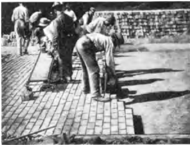
Abb. 192. Setzen der Klinker in 4 Reihen und im Verband [D 98].
