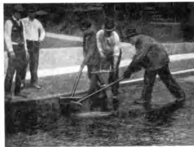
Abb. 193. Übergießen der Klinkerdecke mit heißem Bitumen zur Ausfüllung der Fugen [D 98].
