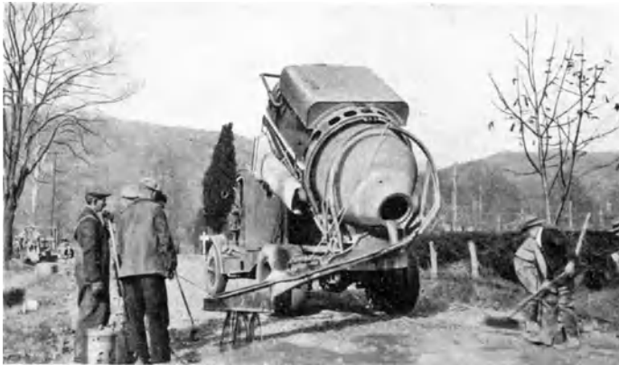
Abb. 181. Aufbringen des Mörtels für eine Zementschotterdecke mittels einer Gießrinne vom Förderwagen (Portland Cement Association, Chicago).
