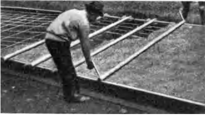
Abb. 171. Ausführung einer Betondecke mit Einlage eines Stahlnetzes mittels Rohren und an diesen befestigten Haken. Durch Drehung der Rohre wird das Netzwerk nach Einbringen des Betons frei [C 106].
