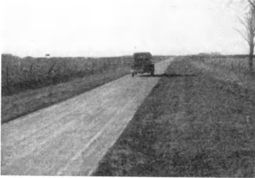
Abb. 131. Einseitige Betonspur in Iroquois County [C 114].
