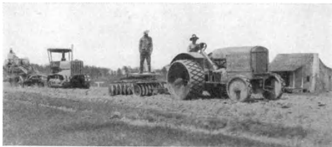
Abb. 65. Bearbeitung einer Tonsanddecke mit der Scheibenegge [C 179].
