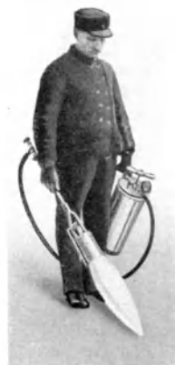
Abb. 112. Ölbrenner zum Erwärmen und Erweichen von Fehlstellen in Bitumendecken [D4].
