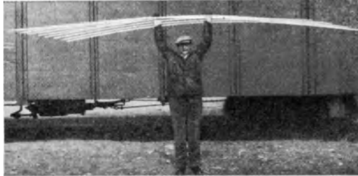
Abb. 136. Elektrisch geschweißte Stahlnetze in Tafelform [A 67].
