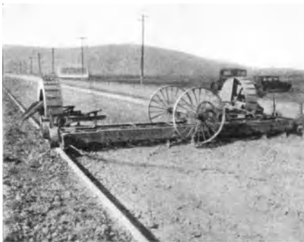
Abb. 141. Gezogener Kratzer mit seitlicher Abbeförderung des Bodens bei der Herrichtung des Planums für eine Betondecke [C 145].
