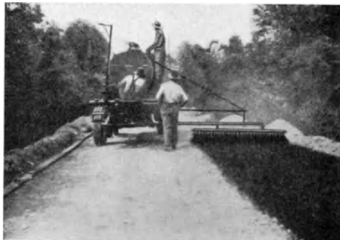
Abb. 98 a. Sprengstreifen seitlich des Drucksprengwagens.
