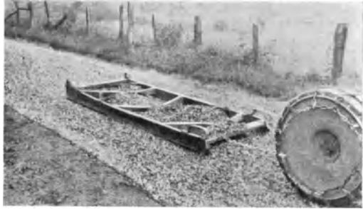
Abb. 77. Glätter mit großer Arbeitsfläche (long base drag) bei der Arbeit [C 137].
