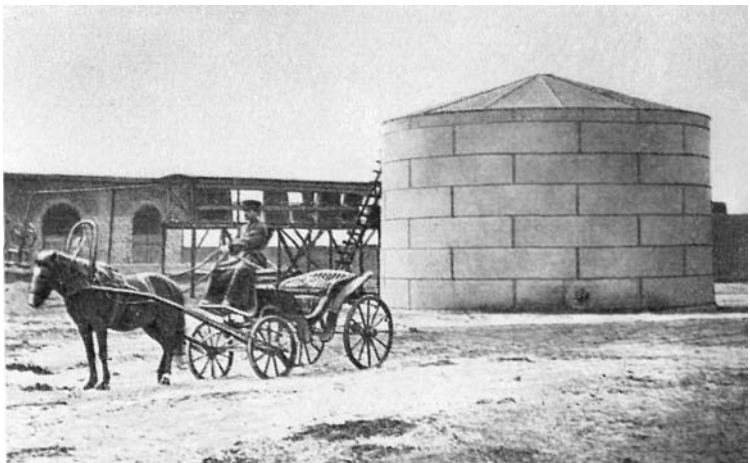
Один из первых шуховских резервуаров
