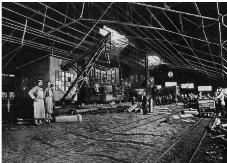
Шуховское покрытие мартеновского цеха на Лысьвенском заводе (1901 г.)
