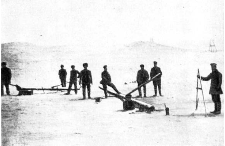
Прокладка опытного участка нефтепровода в Баку
