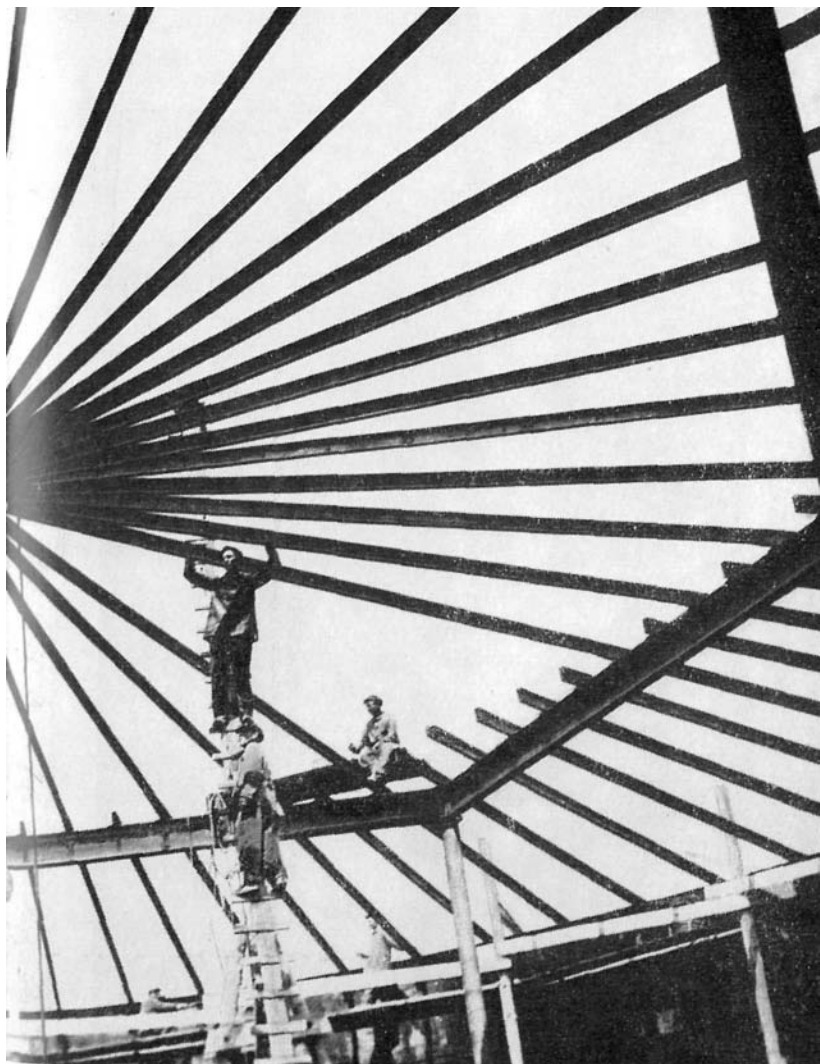
Монтаж покрытия шуховского резервуара большой емкости
