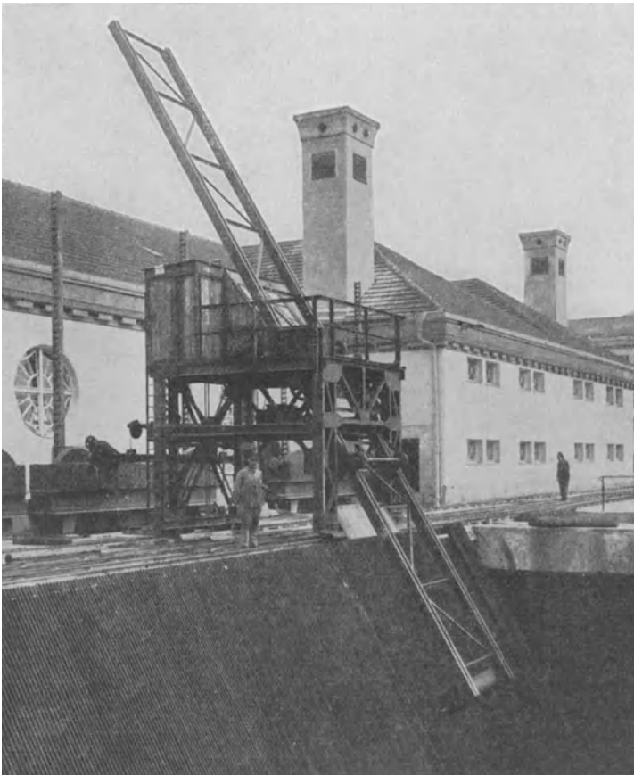
Abb. 43. Rechen-Reinigungsmaschine der MAN.
