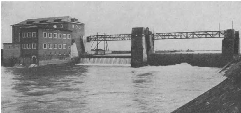
Abb. 16. Walzenwehr im Main bei Viereth.
