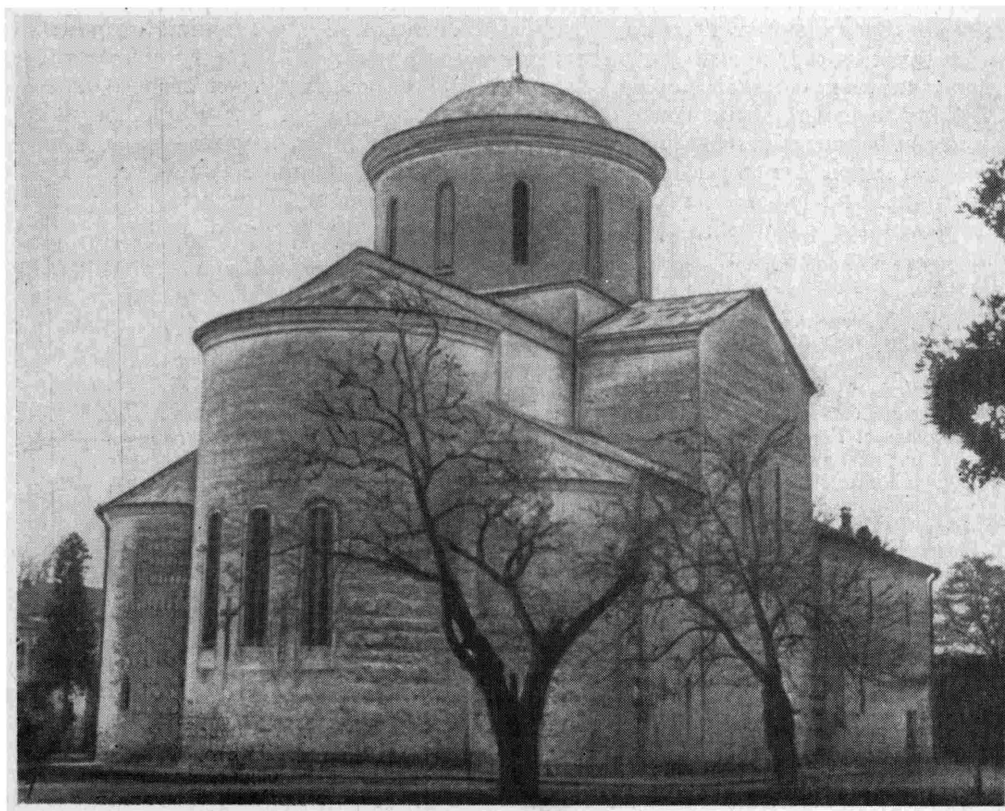
Рис. 2. Храм в Пицунде 1 — вид с северо-востока;
