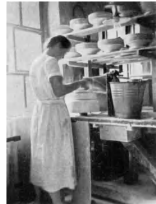
Abb. 2. Tellerrändeln, Verputzen (mit Staubabsaugung).
