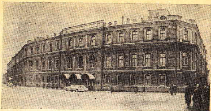
Здание штаба тыла Ленинградского фронта по улице Толмачева, 1
