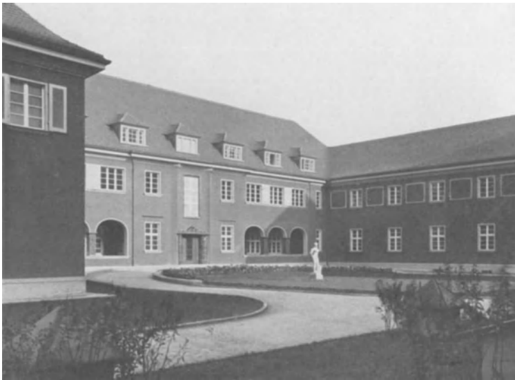
Abb. 16. Innenhof des Anbaues.
