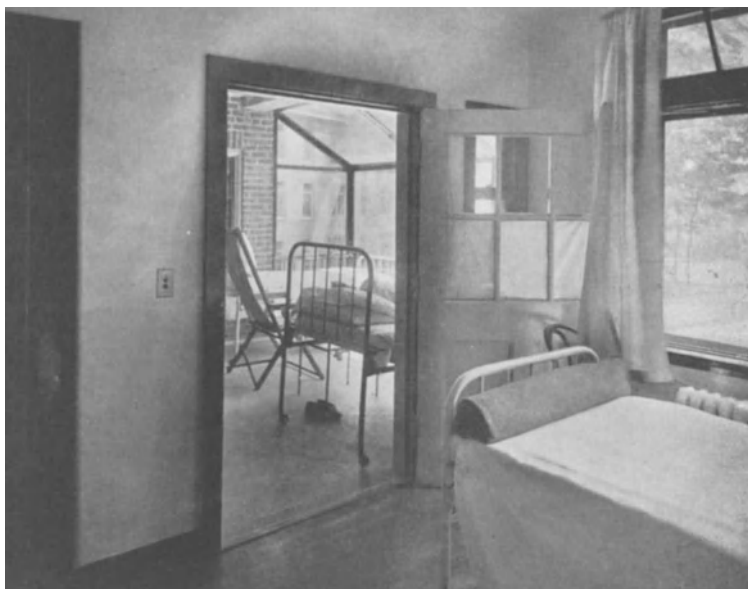
Abb. 14. Einzelzimmer im Wm. H. MAYBURG Sanatorium (Detroit Municipal) Northville, Michigan.
