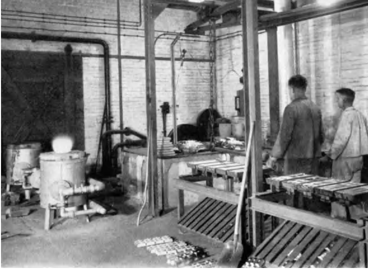
Abb. 124. Teilansicht einer Zinklegierungsanlage.
