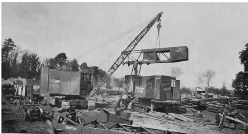
Abb. 528. Diesel-Universalbagger auf Raupen als Kran auf einem Montageplatz in Irland beim Bau des Shannonwerkes (Siemens-Bauunion G. m. b. H., Berlin).
