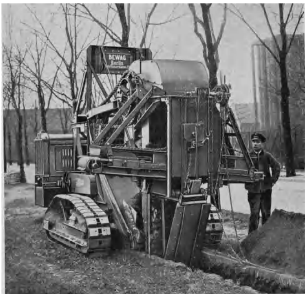
Abb. 424. Barber-Greene-Bagger im Dienst der Berliner Städt. Elektrizitätswerke.
