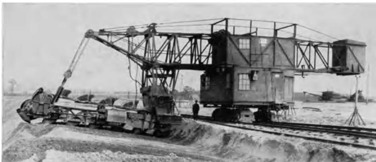
Abb. 713. Absetzer mit geführter Eimerkette und festem Oberbau (LMG).
