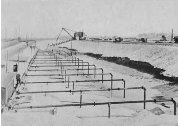
Abb. 857. Staffel I der Grundwasserabsenkung im Betrieb. Im Hintergrund Bagger I.
