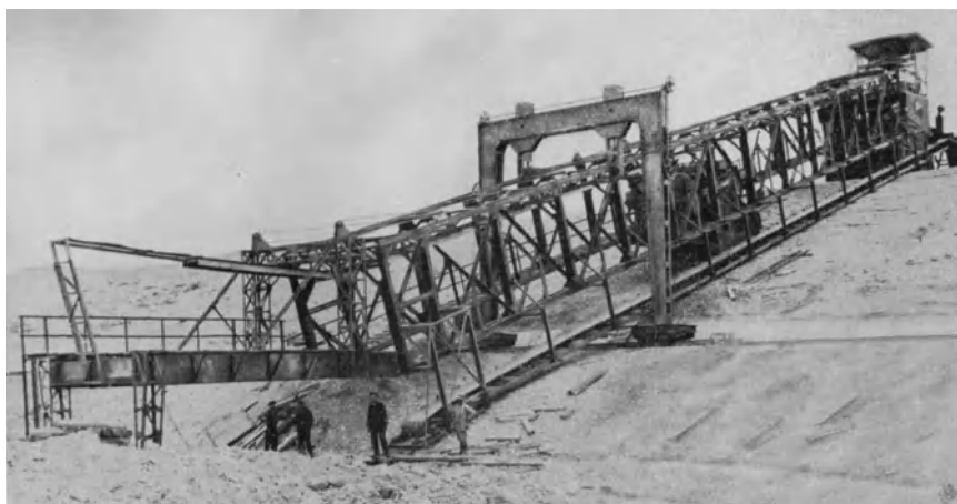
Abb. 675. Böschungsplaniermaschine beim Bau des Rheinkraftwerks Kembs (Dinglerwerke).
