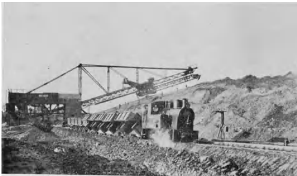
Abb. 726. Hoch-Absetzer mit Doppelband beim Dammschütter für die Shannon-River-Kraftanlage (Krupp, LMG, Buckau).
