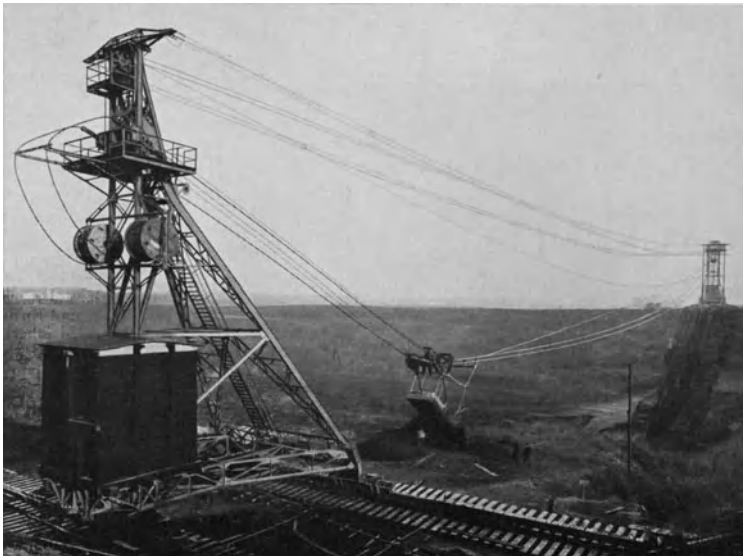
Abb. 749. Kabelbagger der Gewerkschaft „Friedrich“ in Hungen (Hessen). Gegenturm auf Schienen.
