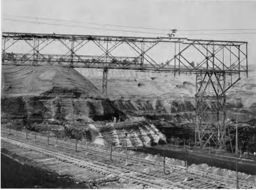
Abb. 828. Montage einer Brücke mit Hilfe von Derricks und Kabelkranen (Brücke Böhlen).
