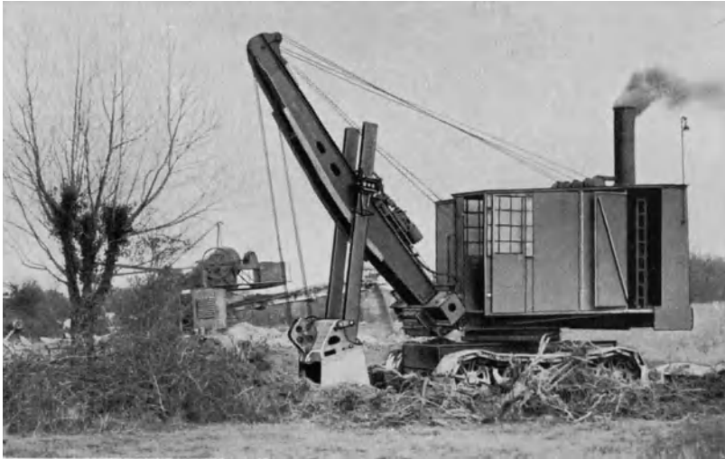
Abb. 878. Raupen-Löffelbagger beim Heckenroden.
