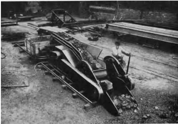
Abb. 573. Schaufellader (Berlin-Anhaltische Maschinenbau A. G., Berlin).
