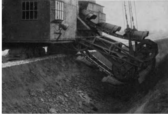
Abb. 730. Doppel-Turas-Führung der Eimerkette eines Buckauer Schwenkabsetzers im Schöpfgraben.
