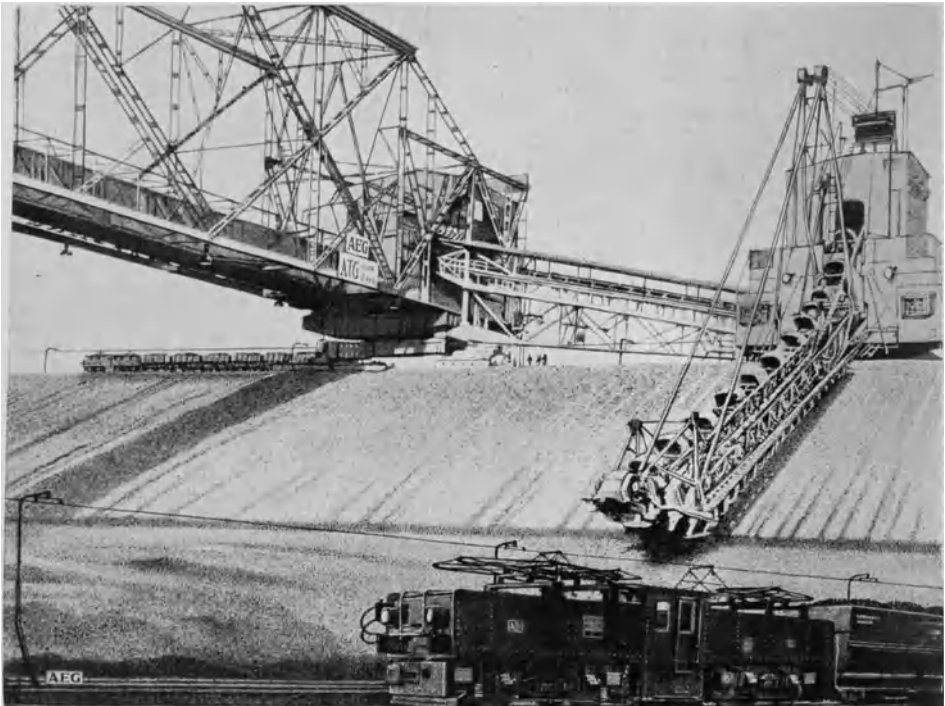
Abb. 783. Abraumförderbrücke, gekuppelt mit einem auf der gleichen Strosse arbeitenden Tiefbagger auf Grube „Roberts Hoffnung“.
