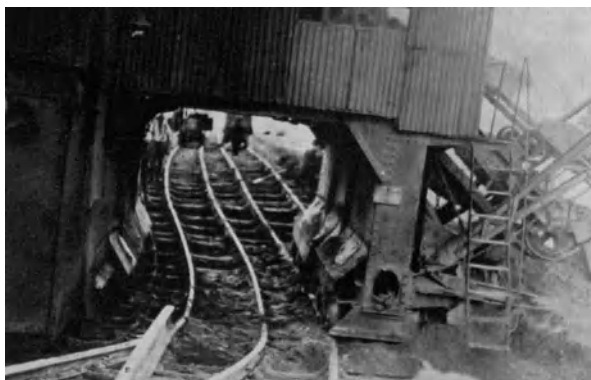
Abb. 254. Rutschungen in der Baggerböschung.
