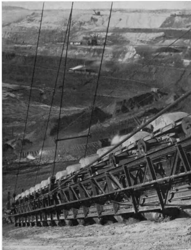
Abb. 370. LMG-Bagger für 41 m Baggertiefe, Blick vom Führerstand auf die Eimerleiter.
