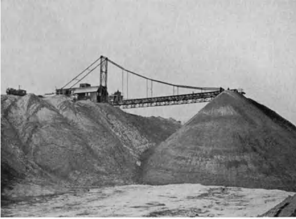
Abb. 704. Absetzer (Krupp) auf Grube „Fortuna“ bei Köln.
