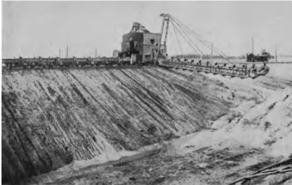
Abb. 849. Bagger III bei Kanal km 57,1.
