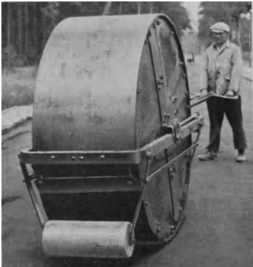
Abb. 681 b. 1,4 t-Motoreinradwalze (Schwartzkopff).
