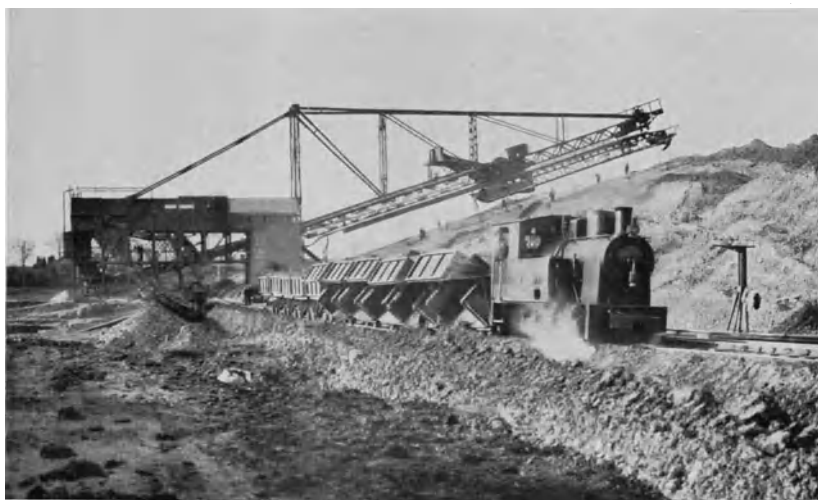
Abb. 883. Absetzapparat 18 m Schütthöhe, 40 m Schüttweite beim Dammschütten.
