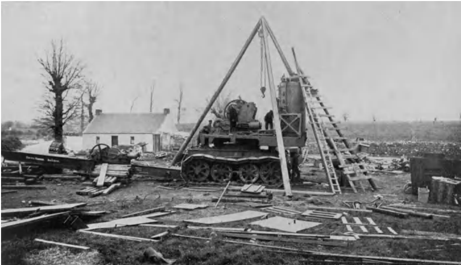
Abb. 226. Montage eines 2 m 3 -Raupenlöffelbaggers.
