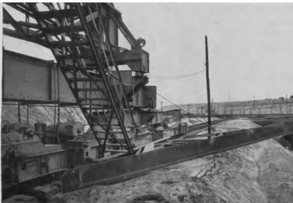
Abb. 893. Pflugschar zum Herstellen des Planums für die Förderbrückenstütze.
