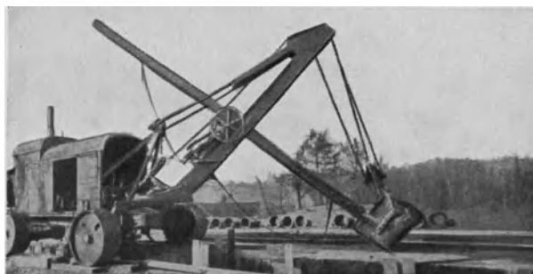
Abb. 3. Löffelbagger auf Straßenrädern.
