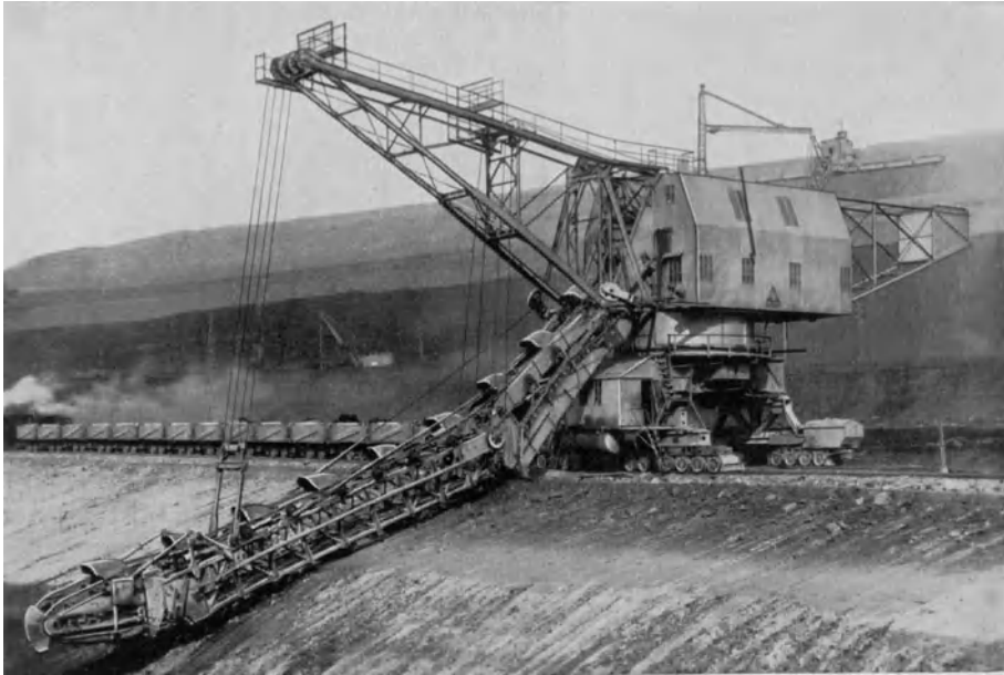
Abb. 413. 500 t-Großtor-Schwenkbagger im Abraum auf Grube Treue (Krupp).
