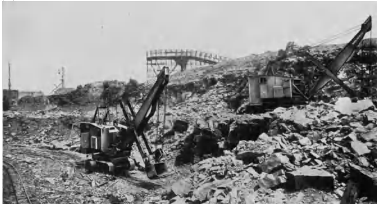
Abb. 214. Zwei 3\frac{1}{3} m 3 -Elektro-Löffelbagger auf Raupen beim Bau des Pumpspeicherwerks Hengstey, Modell E (Menck & Hambrock).
