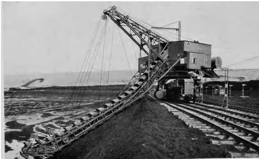
Abb. 410. Eintor-Schwenkbagger, 16 + 15 m Abtragshöhe (Buckau).
