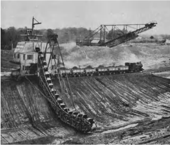
Abb. 880. 250 l-Elektro-Eimerkettenbagger beim Obergrabenaushub (Krupp, LMG, Buckau.)
