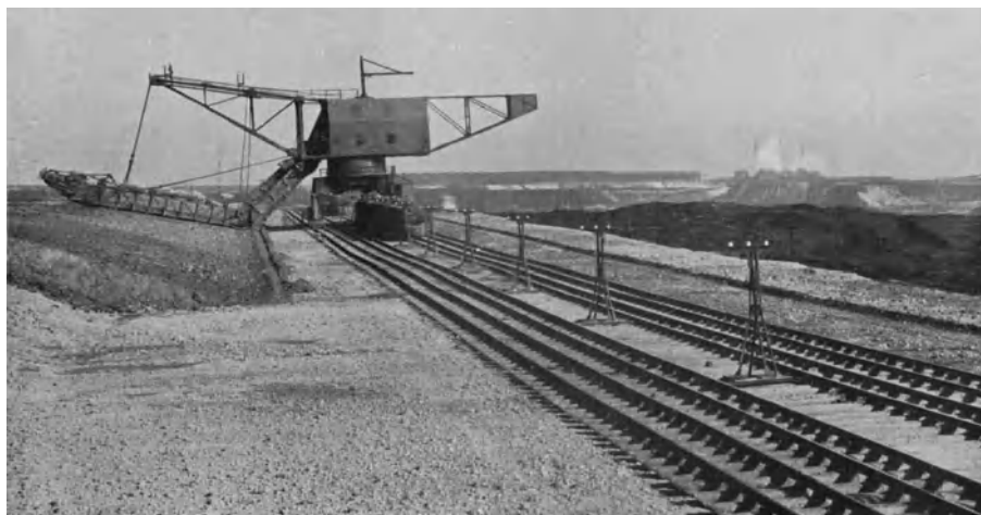
Abb. 464. Gleisanlage für einen Großtor-Schwenkbagger mit eisernen Schwellen (Vereinigte Stahlwerke).
