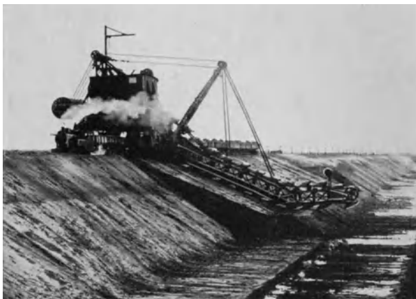
Abb. 261. Buckauer Tiefbagger D 700 mit 6 bis 8 m langem, sich selbstständig einstellendem Planierstück.
