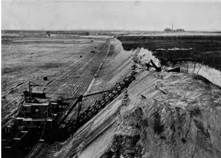
Abb. 895. Elektrischer Löffelbagger als Hilfsgerät am Abraum-Hochbaggerstoß.
