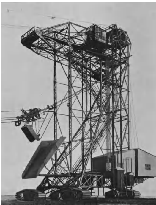
Abb. 750. Maschinenturm auf Raupenfahrwerk des Kabelbaggers der Gewerkschaft „Friedrich“ in Hungen (Hessen).
