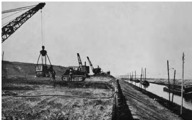
Abb. 863. Bodenverdichtung durch Raupenschlepper.
