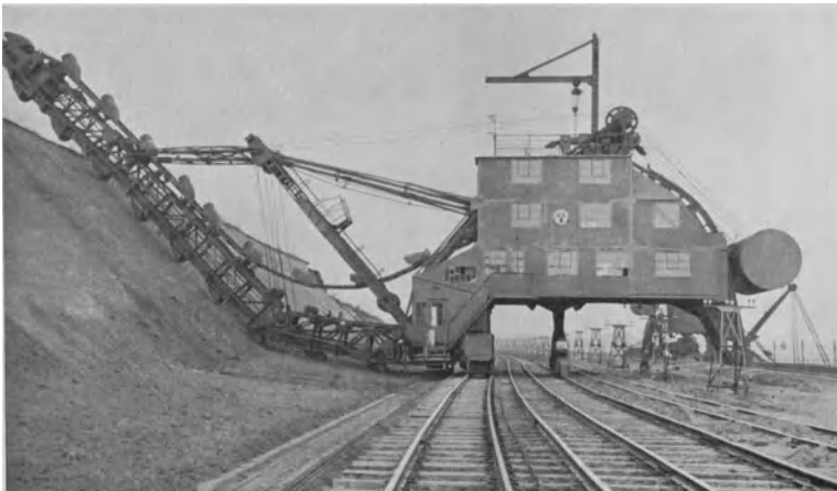
Abb. 273. Doppeltor-Hochbagger (Mitteldeutsche Stahlwerke A. G.). Parallelaufhängung der Hochbaggerleiter.
