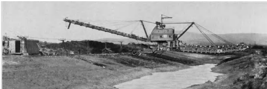
Abb. 392. 2501-Kanalbagger mit rd. 50 m langem Transportband (LMG).
