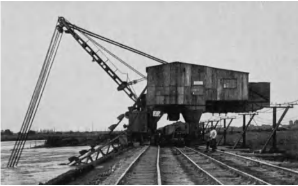
Abb. 868. Elektro-Eimerkettenbagger 250 l Inhalt beim Baugrubenaushub (LMG).
