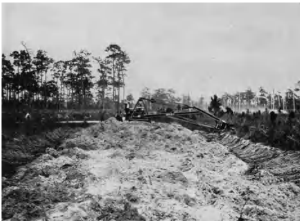
Abb. 516. Tieflöffelbagger mit Rohölantrieb beim Eisenbahnbau (Insley Manufacturing Co., Indianapolis).
