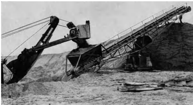
Abb. 896. Elektrischer Löffelbagger mit Gurtförderer beim Schütten eines Dammes.
