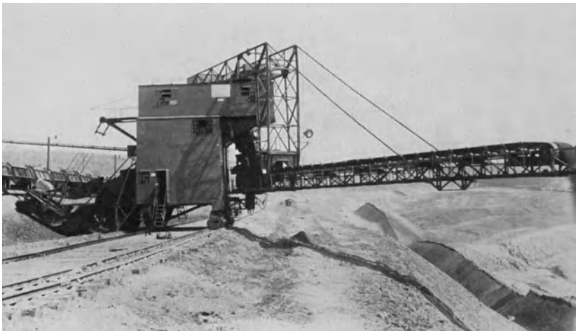
Abb. 728. Absetzer mit schwenkbarem Band, 400 l Eimerinhalt, 27,5 m Ausladung (LMG).
