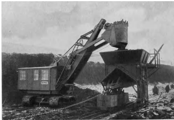
Abb. 199. Löffel mit kurzen Zähnen (alte Ausführung Demag).
