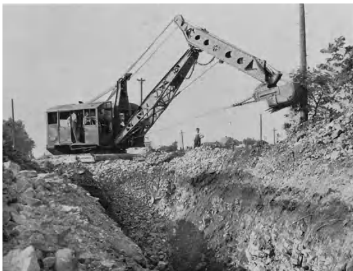
Abb. 651. Sonderbauart eines Tieflöffelbaggers für harten Boden (Page Engineering Co).
