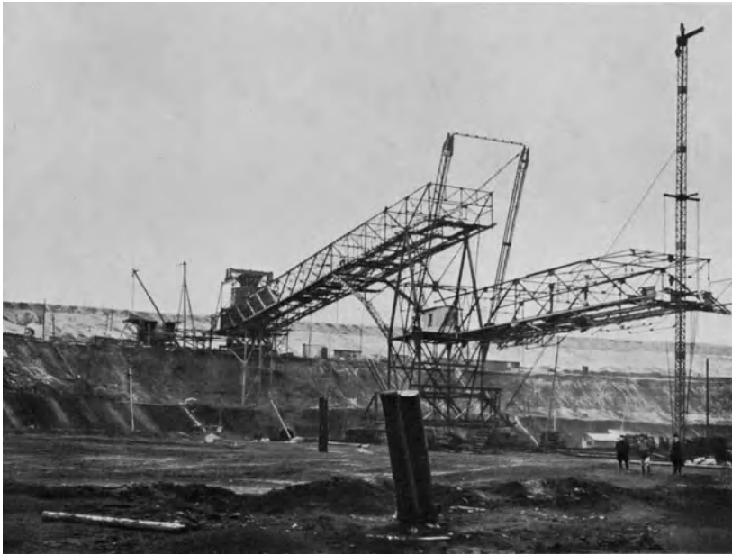
Abb. 827. Hochziehen des Auslegers auf Grube „Alwine“.
