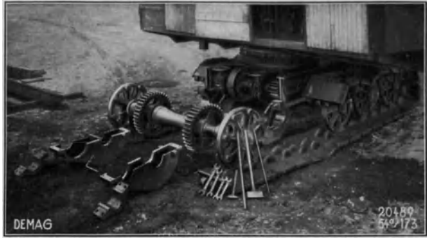
Abb. 119. Ausbau der vollständigen Turasache durch waagrechtches Herausrollen auf der aufgeklappten Raupe (Demag).
