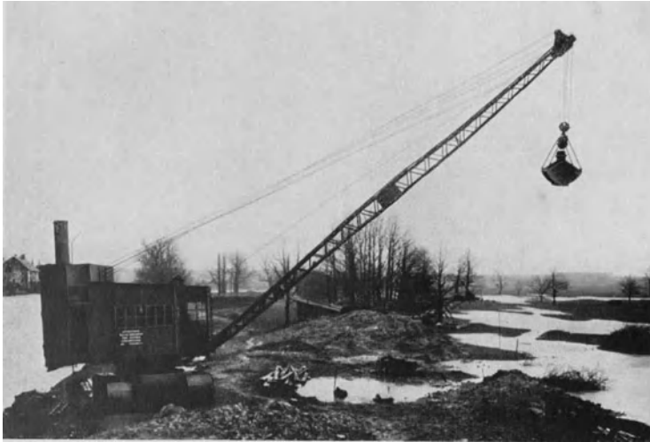
Abb. 63. Greifbagger auf Raupen mit großer Ausladung, den Aushub unmittelbar absetzend (Bünger).
