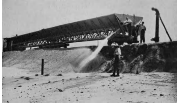
Abb. 694. Spülkipp- und Sumpfverfahren: Der Wasserwagen beim Abspülen.
