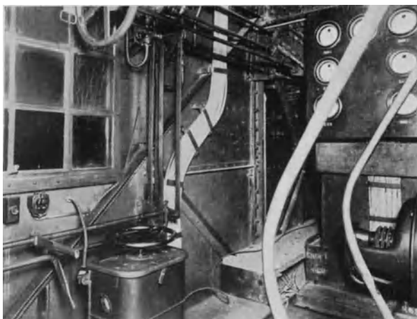
Abb. 371. Führerstand eines älteren Drehstrombaggers (LMG).
