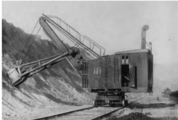
Abb. 222. Arbeiten eines Dampf-Löffelbaggers auf langem Gleis (Menck & Hambrock).
