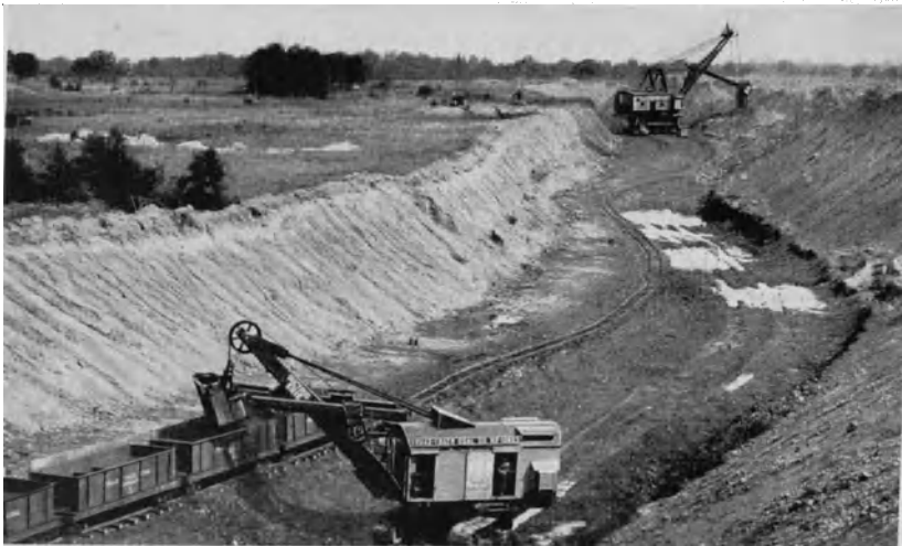
Abb. 596. Amerikanischer Steinkohlen-Tagebau. (2 m 3 -Löffelbagger für Kohle; im Hintergrunde Groß-Löffelbagger von etwa 9 m 3 Löffelinhalt bei der Abraumbeseitigung.)
