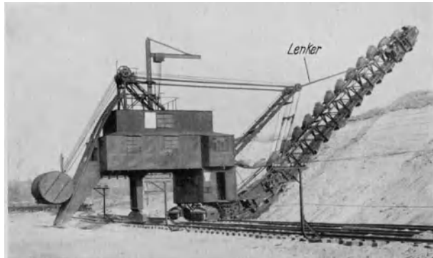
Abb. 402. Eintorbagger, Type E II, mit elektr. Antrieb, als Hochbagger arbeitend (LMG).
