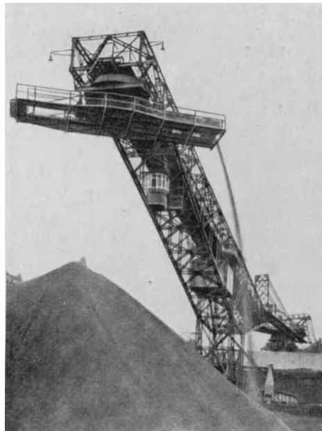
Abb. 797. Ausleger mit schwenkbarem Abwurfband der Brücke Hürtherberg.
