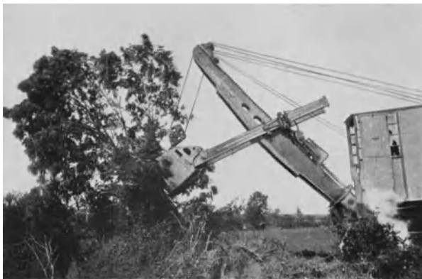
Abb. 211. \frac{2}{3} m 3 -Dampf-Löffelbagger auf Raupen beim Entwurzeln eines Baumes, Modell III (Menck & Hambrock).
