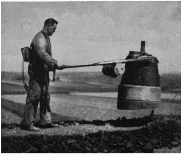
Abb. 667. Delmag-Frosch bei Verdichtungsarbeiten.
