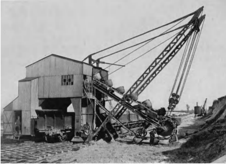
Abb. 241. Lübecker Hoch-B-Bagger mit Kurz-Leiter (LMG).
