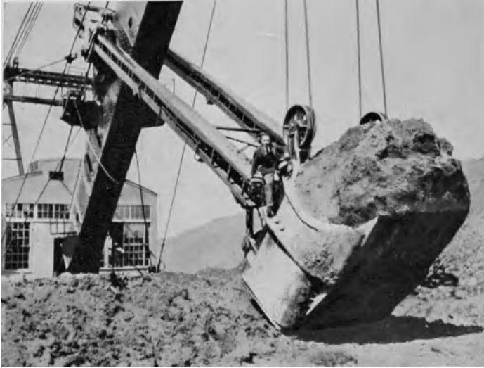
Abb. 642. Doppelter Löffelstiel des „Bucyrus-Erie 750-B“ (16 m 3 Löffel).
