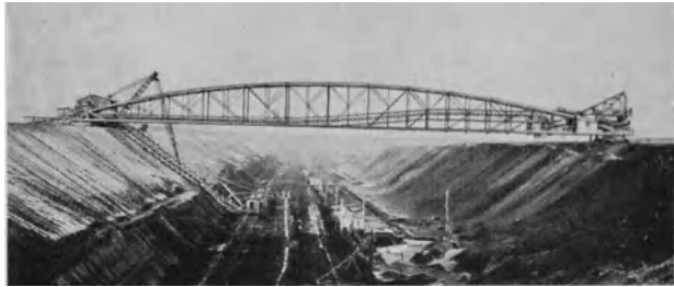
Abb. 785. Abraumförderbrücke aus dem Jahre 1924 für die Bubendorfer Kohlenwerke (ATG) 1 .
