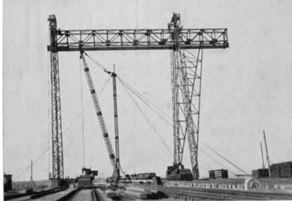
Abb. 487. Eimerkettenbagger-Montage mit Bockkran (LMG).
