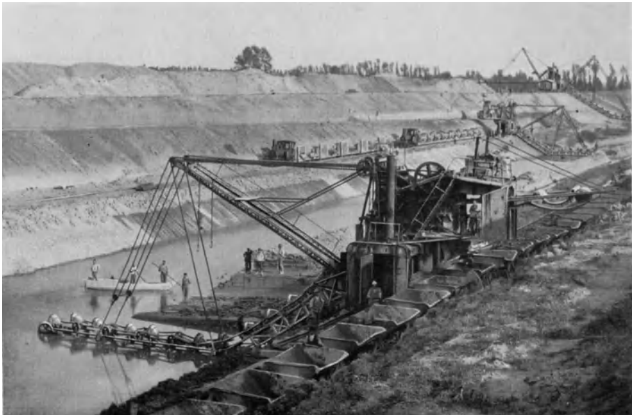
Abb. 264. Profilmäßiger Kanalaushub mit Hilfe entsprechend geknickter Eimerleitern (Lübecker A- und C-Bagger).
