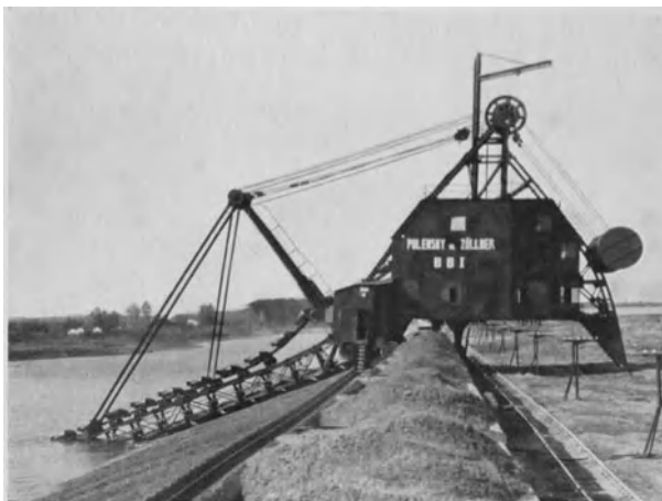
Abb. 833. Doppeltorbagger (Buckau), 830 I Eimerinhalt, an der Entnahmestelle Barleben mit Vollzug (Wagen 16 m 3 Inhalt).
