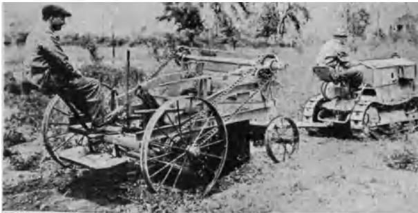
Abb. 538. Schlepper mit angehängtem Schrapper zum Mutterbodenabhub.
