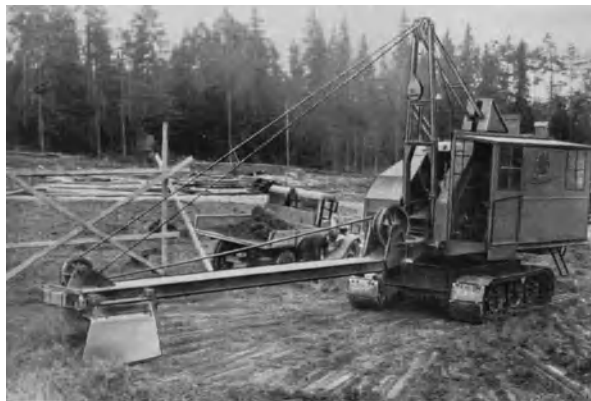
Abb. 527. Planierbagger beim Straßenbau (Menck & Hambrock).
