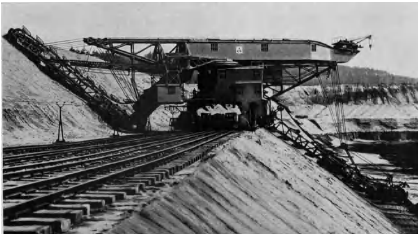
Abb. 406. Verbundbagger (Buckau).
