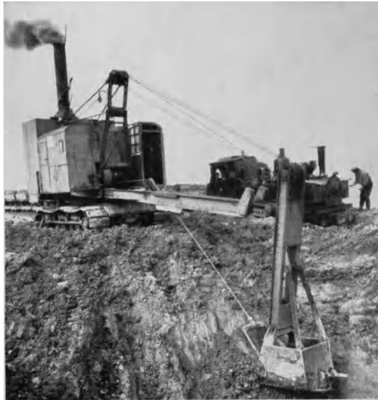
Abb. 525. Tieflöffelbagger (Orenstein & Koppel).
