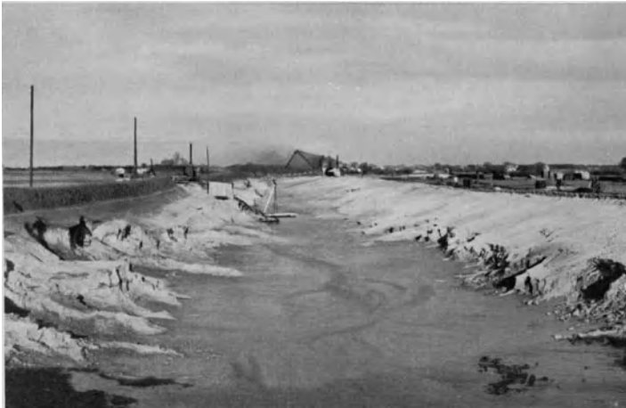
Abb. 855. Bagger I (im Hintergrund) hat die Arbeit eingestellt.
