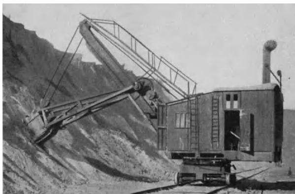
Abb. 2. Schienen-Löffelbagger (Menck & Hambrock G. m. b. H., Altona-Hamburg).
