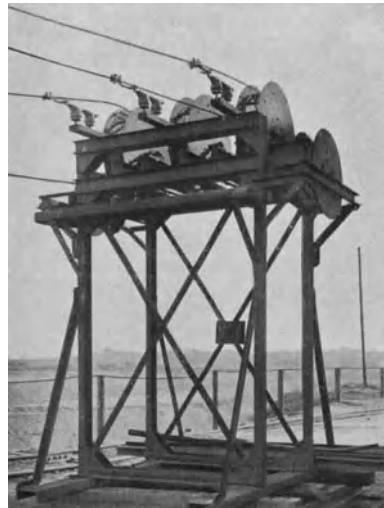
Abb. 474. Abspannbock für Baggerfahrleitungen, ältere Ausführung (AEG).
