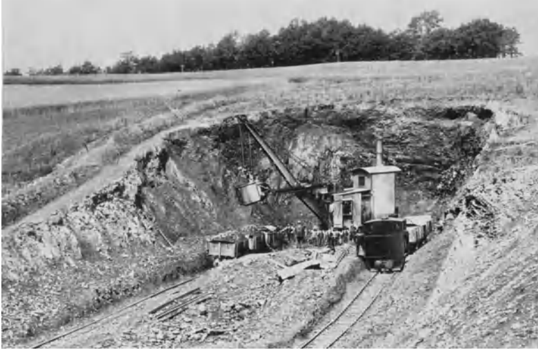
Abb. 216. 2 m 3 -Dampf-Löffelbagger auf Schienen bei Herstellung eines Einschnittes in schwerem Boden auf gleichem Planum arbeitend (Menck & Hambrock).
