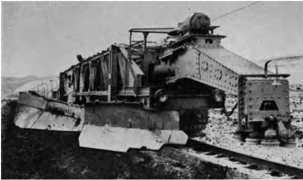
Abb. 663b. Elektrisch angetriebener Lauchhammerpflug beim Pflügen, Gleisrückausleger hochgehoben.
