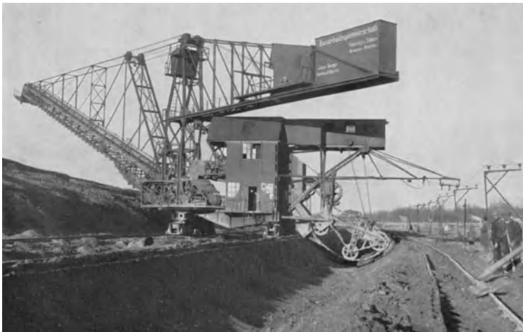
Abb. 743. Schwenk-Absetzer bei der Schüttung des Staudammes Ottmachau (Krupp).
