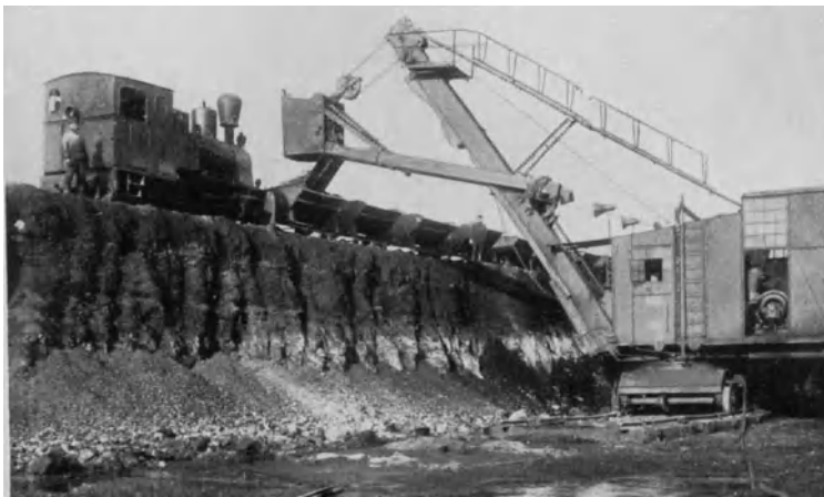
Abb. 219. Baggerung am hohen Gleis mit einem 2,5 m 3 -Elektro-Löffelbagger auf Schienen mit 2 Motorenantrieb (Weserhütte), 2. Motor für den Vorschub.
