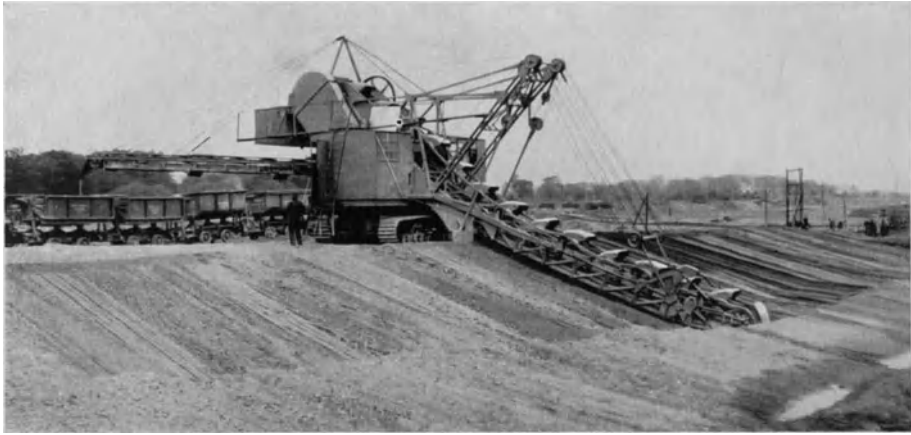
Abb. 397. 75 I-Raupenbagger, Type R III s beim Kanalaushub (LMG).
