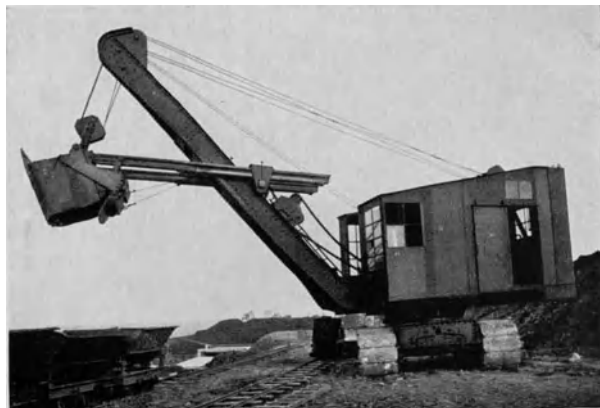
Abb. 192. Kettenantrieb der Löffelstiel-Vorschubwelle bei einem Diesalbagger (Bünger).
