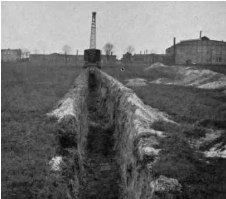
Abb. 515. Grabenaushub mit einem Eimerseilbagger (Orenstein & Koppel).
