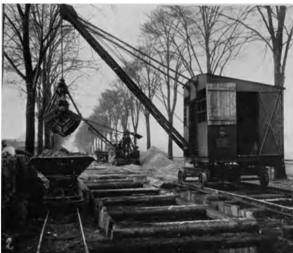
Abb. 65. Vierseilgreifbagger beim Aushub zwischen Kanalsteifen (Bünger).
