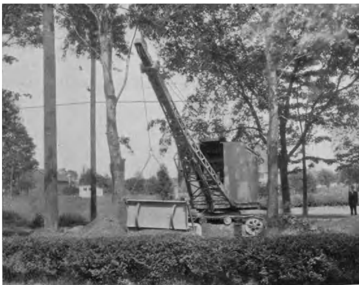
Abb. 601. Zufüller („Backfiller“) beim Einebnen von Gräben (Buckeye).
