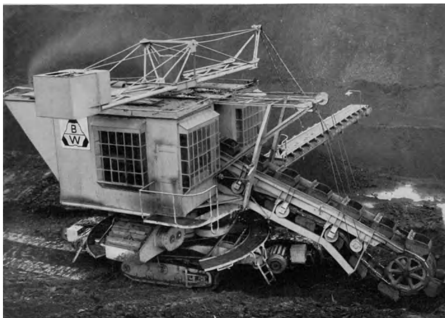
Abb. 437. 50 l-Schaufler-Eimerbagger (Buckau).
