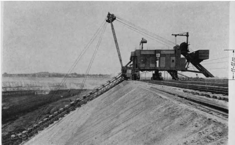
Abb. 403. 650 l-Großtorbagger, 41 m Baggertiefe (LMG).
