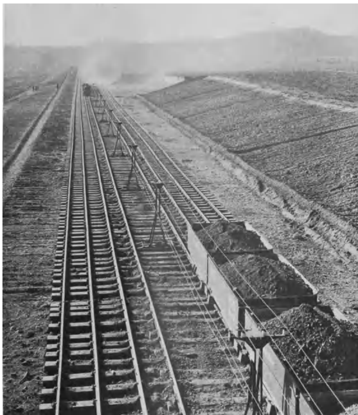
Abb. 463. Gleisanlage nach Abb. 457 IV (Großtor-Schwenkbagger).
