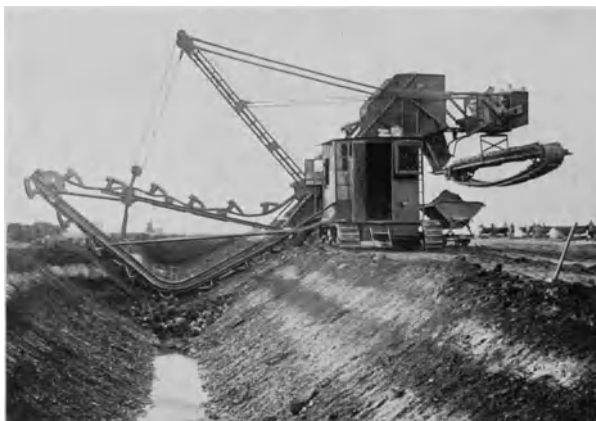
Abb. 400. Raupenbagger, Type ER I, mit Dieselantrieb, gekrümmter Eimerleiter zum Ausheben eines Entwässerungsgrabens und schwenkbarem Transportband (Weserhütte).
