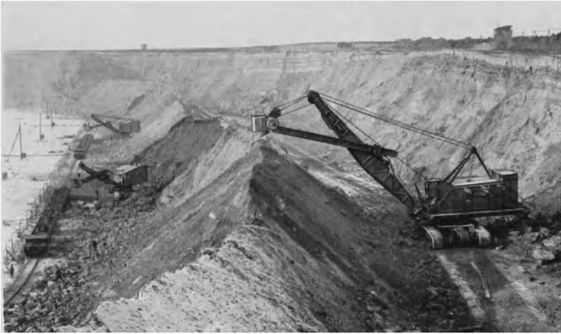
Abb. 209. 5 m 3 -Elektro-Löffelbagger auf Raupen, im geschichteten Kalkstein in Amoeneberg bei Biebrich arbeitend (Menck & Hambrock).
