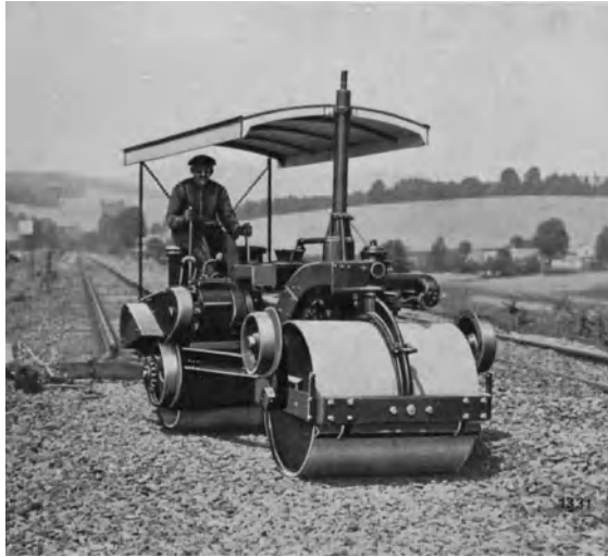
Abb. 679. Tandemwalze mit Gleisfahrteinrichtung bei Bettungsarbeiten (Deutz-Kemna).
