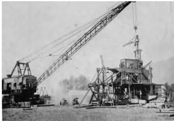
Abb. 488. Eimerkettenbagger-Montage mit Raupe-Eimerseilbagger (LMG).
