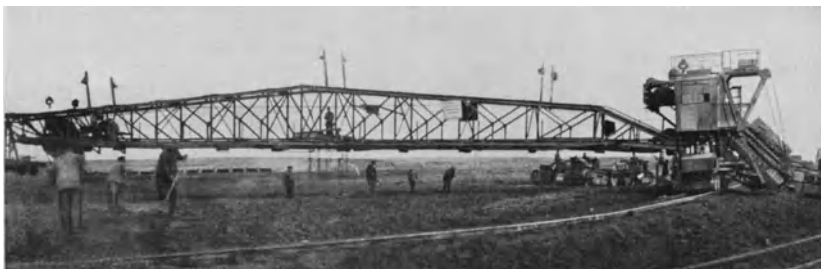
Abb. 841. Einbringen des Tones in die Kanalsole (im verbreiterten Teil des Vorhafens).
