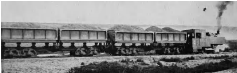
Abb. 837. Vollzug mit 16 \text{ m}^3 -Wagen auf der Kippe. Sichtbar sind die beiden Wagen hinter der Lokomotive.
