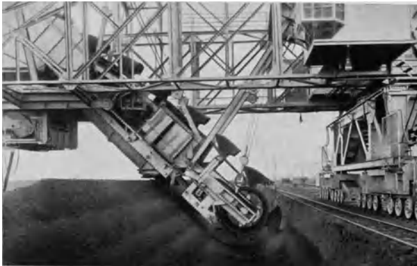
Abb. 718. Aufnahmegraben eines Absetzers mit Eimerkette.
