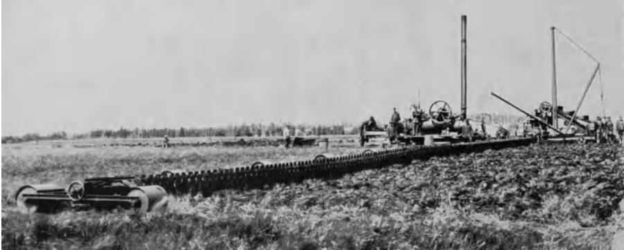
Abb. 590. Plattenband-Sodenableger eines Strenge-Orenstein & Koppel-Torfbaggers.
