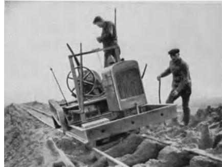
Abb. 839. Absatzweise arbeitende Gleishebe- und -Rückmaschine.
