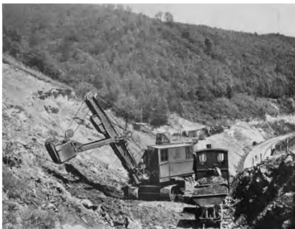
Abb. 212. \frac{2}{3} m 3 -Diesel-Löffelbagger auf Raupen beim Bau einer nur 7,5 m breiten Gebirgsstraße in Graufelsgeröll, Modell III (Menck & Hambrock).
