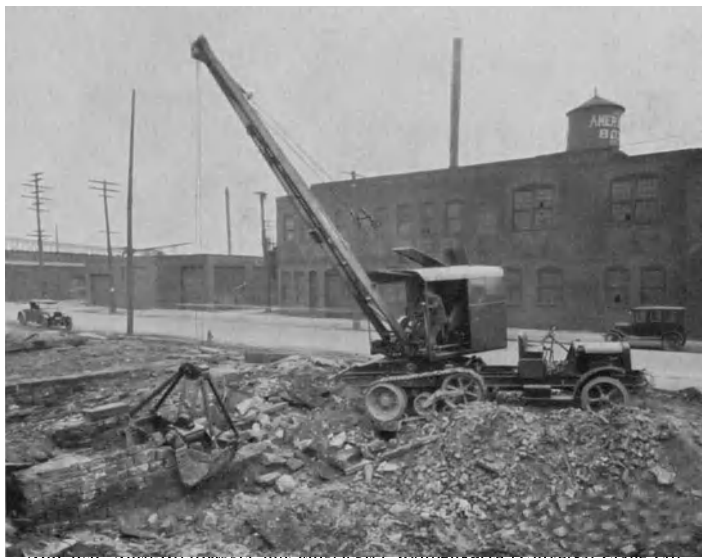
Abb. 627. Auto-Kranbagger mit angelegter Raupenkette (Universal Crane Co.).
