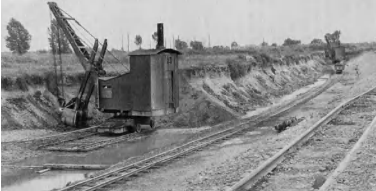
Abb. 218. Dampf-Löffelbagger auf Schienen bei Seitenentnahme und Laden in Planumhöhe (Menck & Hambrock).
