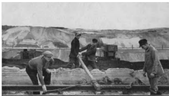
Abb. 897. Schwellen-Verziehen mittels Hebelbaum.
