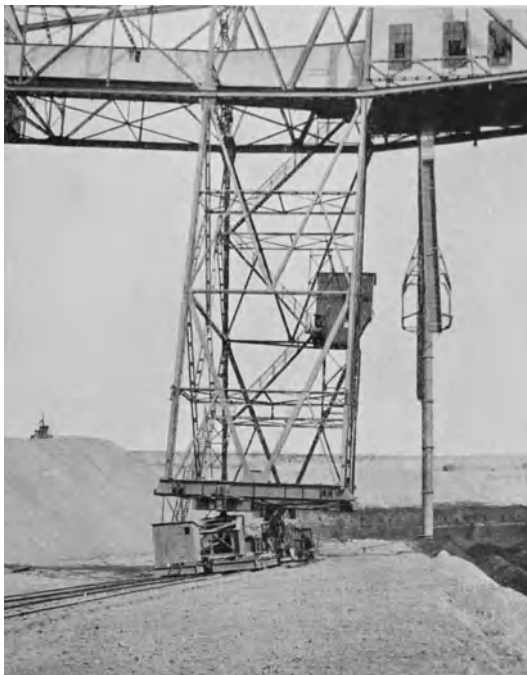
Abb. 793. Brückenstütze mit Schüttrohr und haldenseitigem Fahrwerk der Abraumförderbrücke „Prinzessin Viktoria“ (M. St. W.).
