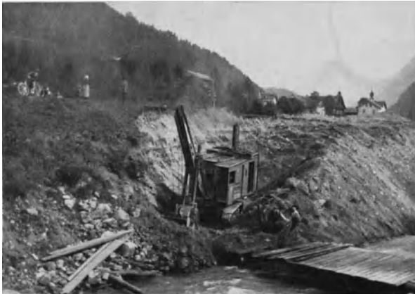
Abb. 210. Unter Planum arbeitender Dampf-Löffelbagger auf Raupen bei Herstellung einer Abfahrtsrampe zu einem Flußübergang in Tirol, Modell III (Menck & Hambrock).
