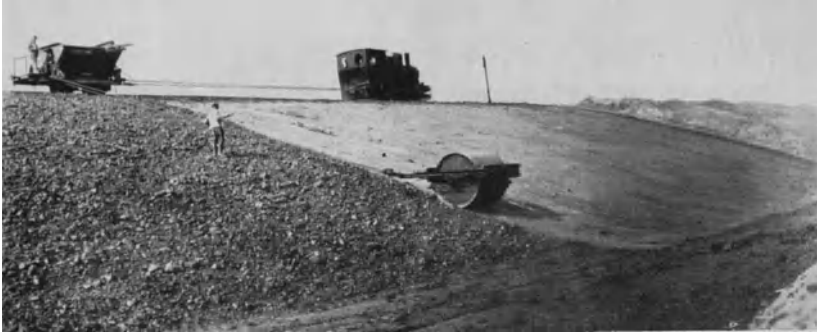
Abb. 842. Einbringen und Verdichten der Tonschale im Kanalbett.
