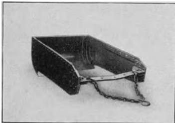
Abb. 548. Mulden- oder Kastenschrapper (Hasenclever).
