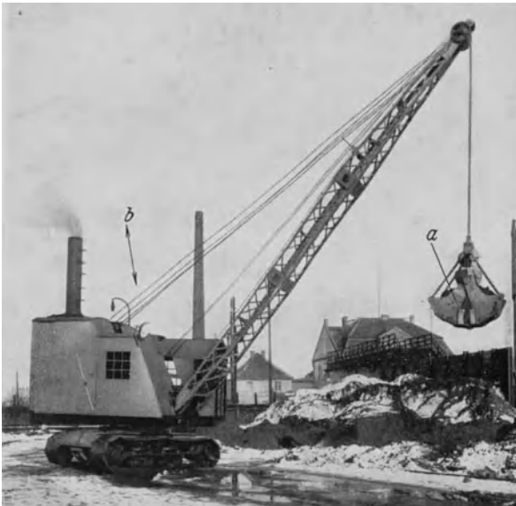
Abb. 5. Greifbagger. a Greifkorb, b raupenfahrbarer Greiferkran (Orenstein & Koppel A. G., Berlin).
