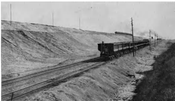
Abb. 838. Auffahrt zur Dammkippe. Ein Vollzug oben auf der Kippe, ein Leerzug im Vordergrund bei der Abfahrt.
