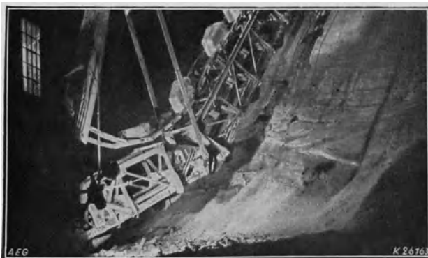
Abb. 378. Beleuchtung der Arbeitsstelle eines Baggers (AEG).
