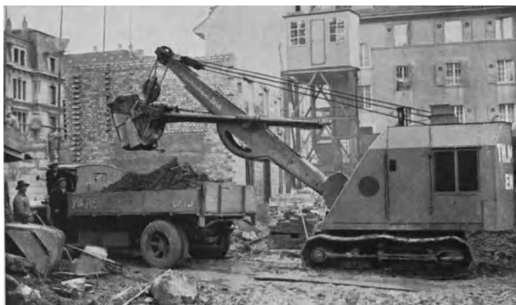
Abb. 195. Rohr-Löffelstiele an einem Kleinbagger (Orenstein & Koppel).
