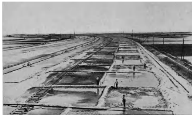
Abb. 696. Spülkipp- und Sumpfverfahren. Einsumpfen einer niederen Kanalstrecke.
