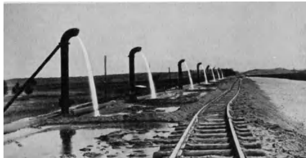
Abb. 695. Spülkipp- und Sumpfverfahren. Einsumpfen der Spüldämme.
