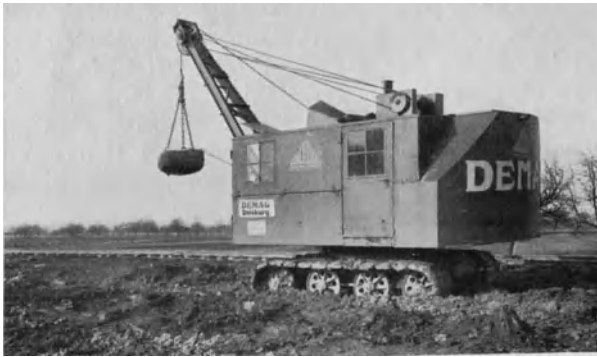
Abb. 669. Stampfer beim Bau der Reichsautobahn bei Heidelberg (Demag, Typ E 20).
