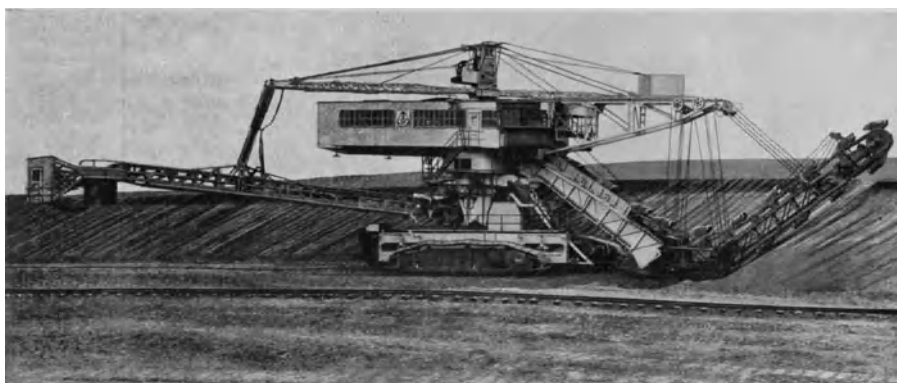
Abb. 417. 150 l-Raupenschwenkbagger, Abtragshöhe 5 + 5 \text{ m} , mit Ausleger-Gurtförderer 125 m (Buckau).
