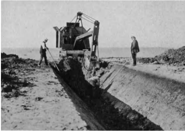
Abb. 514. Raupentieflöffelbagger mit Dieselantrieb bei einer Grabenherstellung (Orenstein & Koppel).
