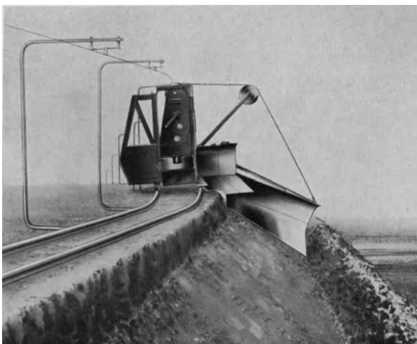
Abb. 658. Arbeitsweise eines Planierpfluges beim Herstellen der Kippmulde.
