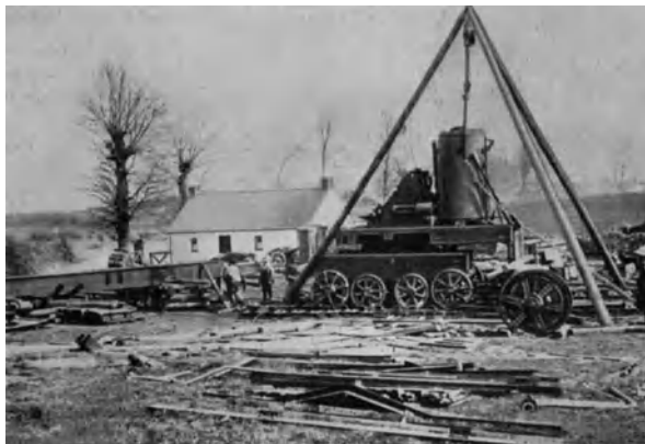
Abb. 71. Montageplatz eines Greifbaggers.
