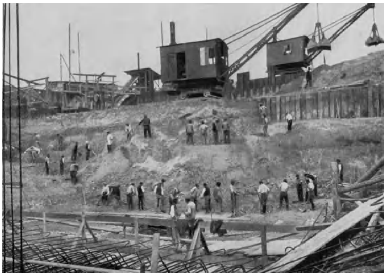
Abb. 62. Greifbagger beim Baugrubenaushub (Menck & Hambrock).
