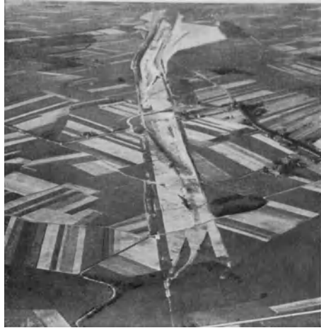
Abb. 852. Luftbild der im Bau befindlichen Kanalstrecke gegen km 60 zu. Freigegeben R.L.M. 3992/36b.
