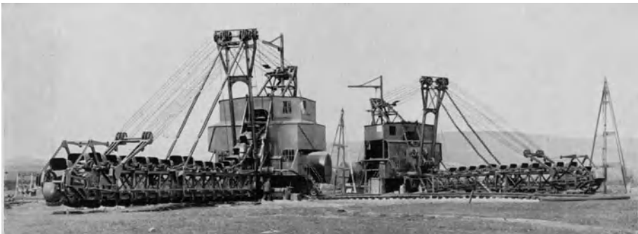
Abb. 484. Eimerkettenbagger-Montage (Buckau).
