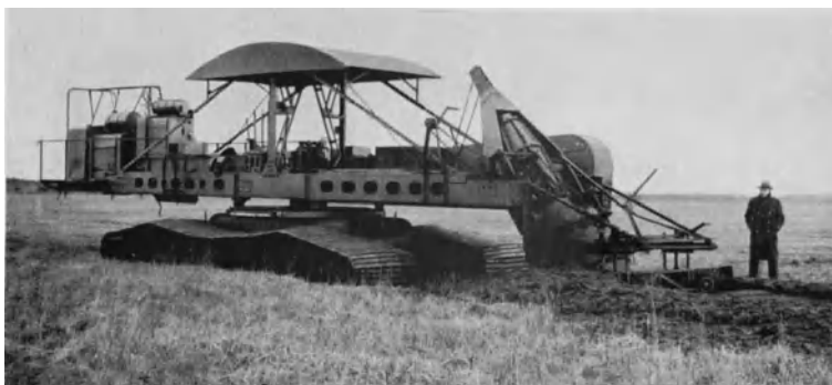
Abb. 593. Universal-Torfräsmaschine (Weserhütte).
