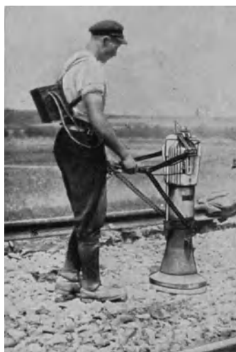
Abb. 666. Explosionsstampfer bei Verdichtungsarbeiten (Delmag).
