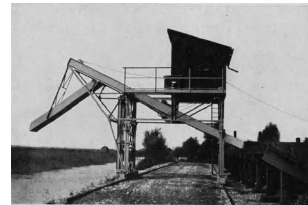
Abb. 563. Überladevorrichtung des Lagerplatzschrapppers in Kähne oder Lastwagen (Hasenclever).
