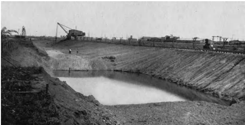
Abb. 870. Baggerfeld mit Strosse und Schleifleitung für den 250 l-Elektro-Eimerkettenbagger.
