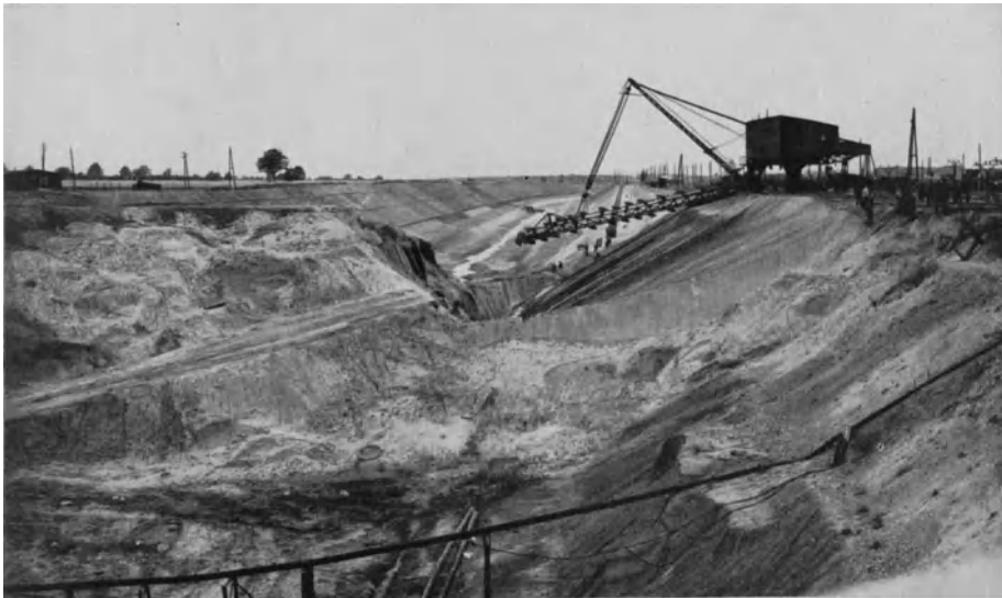
Abb. 251. Elektrischer E-Bagger (LMG) am Mittellandkanal beim Anschneiden.
