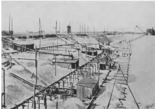
Abb. 858. Grundwasserabsenkungsanlage mit teilweise gezogenen Brunnen der Staffel I.
