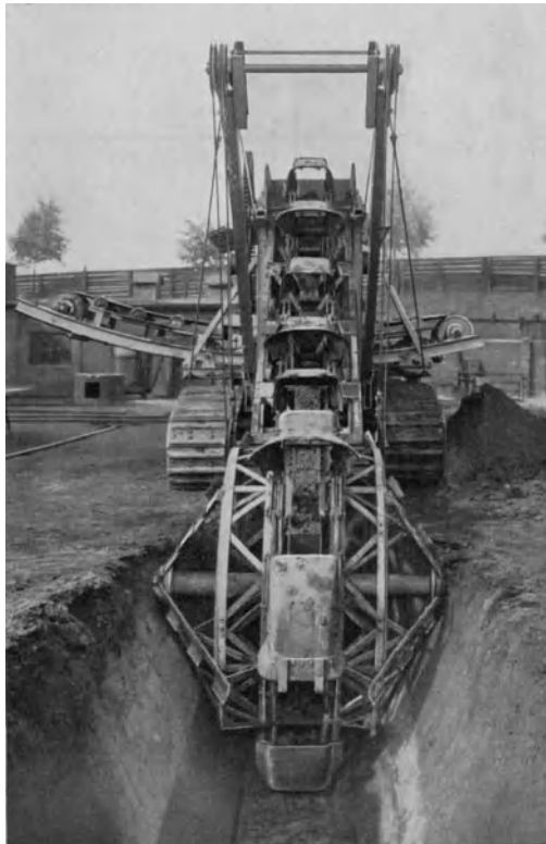
Abb. 434. Grabenbagger der LMG mit Bügelmessern und Böschungsschneider.
