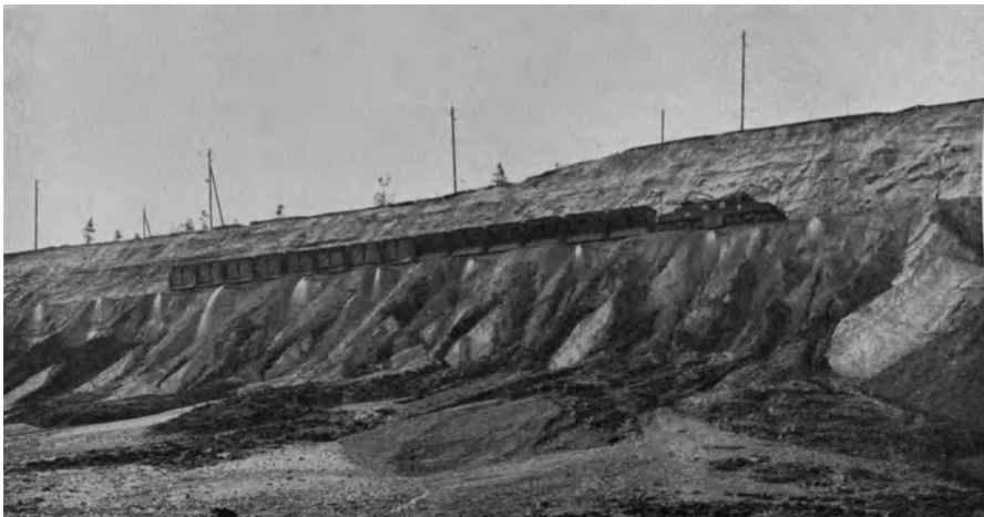
Abb. 687. Ansicht einer Spülkippe in einem Abraumbetrieb.
