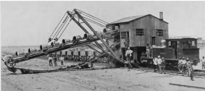
Abb. 242. Erste Bauart des Tiefbaggers (Eintorbagger) mit offenen Eimern (LMG).
