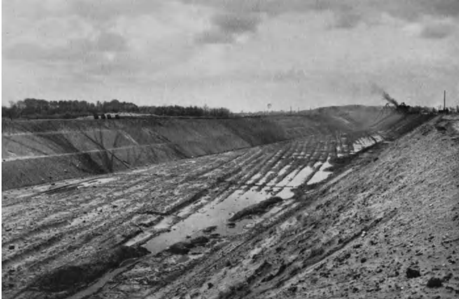
Abb. 453. Aushub einer Strecke des Mittellandkanals bei Abbesbüttel.
