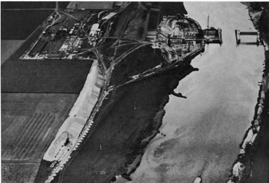
Abb. 869. Luftbild der Schleusen- und Wehrbaustelle. Freigegeben R.L.M. 7062/36.
