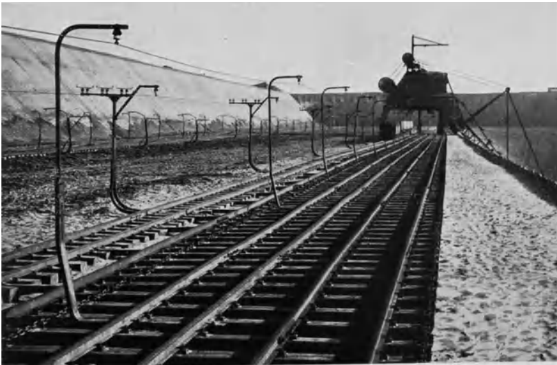
Abb. 462. Gleisanlage nach Abb. 457 III (Doppeltorbagger).
