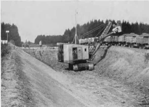
Abb. 217. Diesel-Löffelbagger auf Raupen im Einschnitt vor Kopf am hohen Gleis arbeitend (Menck & Hambrock).
