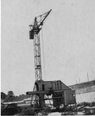
Abb. 485. Eimerkettenbagger-Montage mit Turmdrehkran (LMG).
