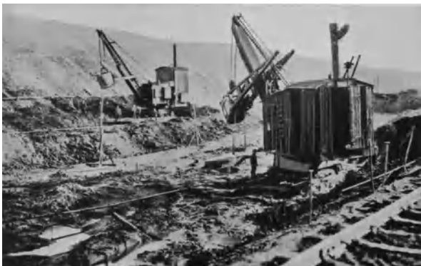
Abb. 851. Kanalaushub unter Leinpfadhöhe durch Löffelbagger.
