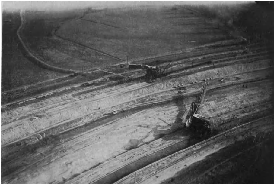
Abb. 744. Schüttung des Staudammes Ottmachau durch zwei Absetzer (Luftaufnahme Nr. 7953, Hansa Luftbild Bonn, freigegeb. lt. Verfüg. d. RLM. vom 4. 12. 1934).
