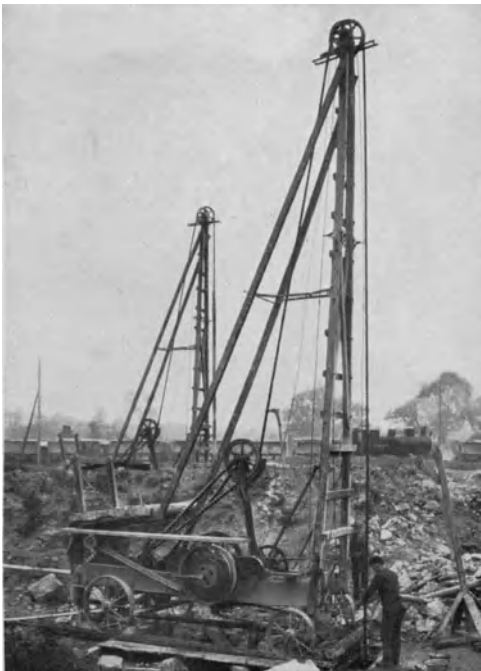
Abb. 881. Freifall-Bohrmaschinen beim Felsaushub.
