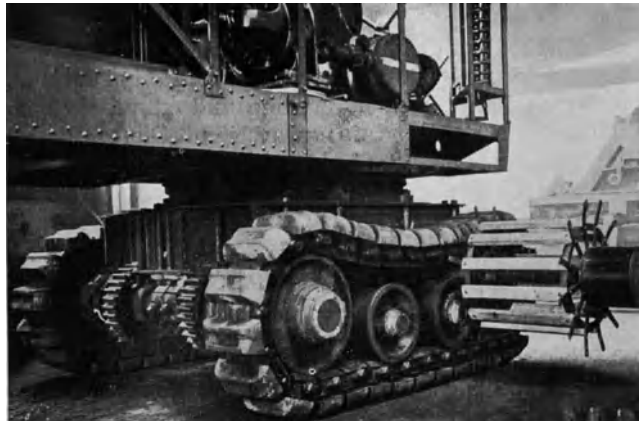
Abb. 108. Raupenkette eines Elektro-Löffelbaggers für Felsbetrieb mit großen Flächendrücken (Menck & Hambrock).
