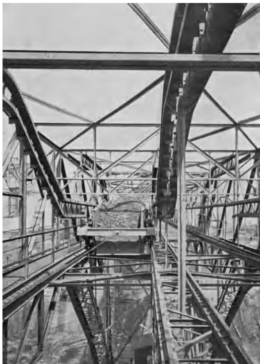
Abb. 805. Förderwagen während der Fahrt, 8 m 3 Inhalt, Förderbrücke Grube „Alwine“.
