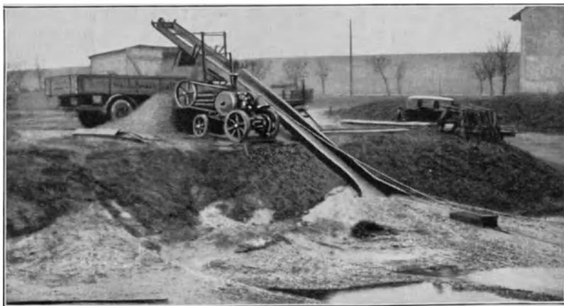
Abb. 544. Kleinschraper beim Arbeiten aus einer Kiesgrube (Nordhäuser Masch.-Fabr. A.-G. Schmidt, Kranz & Co.).
