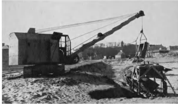
Abb. 521. Entleerungsvorgang beim Eimerseilbagger (Orenstein & Koppel).
