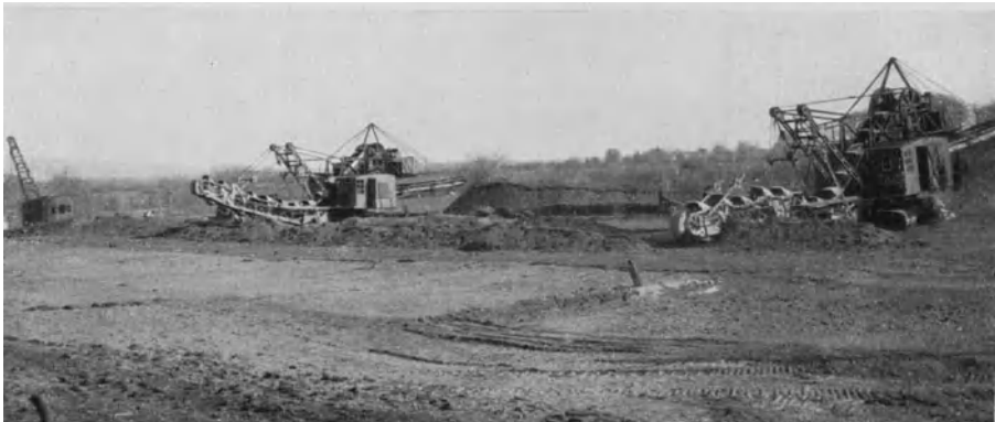
Abb. 396. 75 l-Raupenbagger, Type R IIIs beim Mutterbodenabdecken (LMG).
