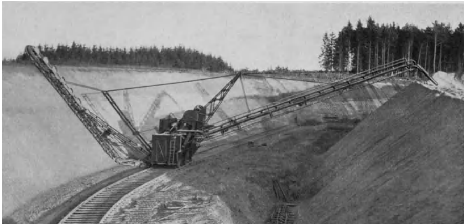
Abb. 391. 301-Bagger, Type 2 (Orenstein & Koppel).
