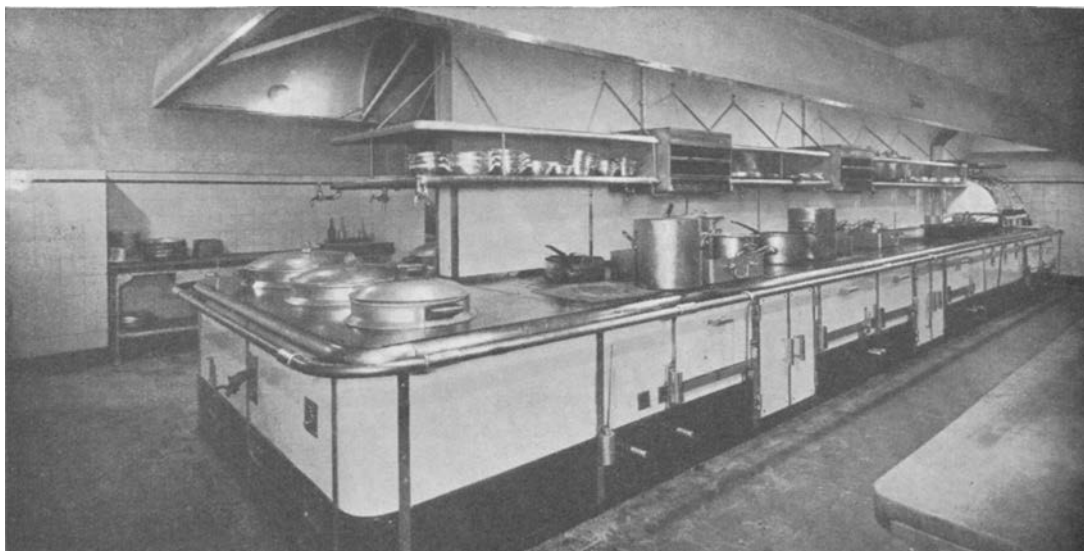
Une cuisine de grand hôtel équipée au gaz. On voit à gauche les bains-marie ; au centre et en haut deux salamandres ; à droite au fond les grills. (Hôtel Ambassador. Phot. C*« du gaz de Paris.)
