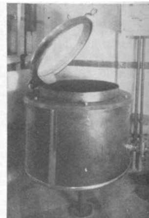
Une grande marmite électrique, installée dans les cuisines de l'École Supérieure d'Electricité de Paris. (Phot. Larousse.)
