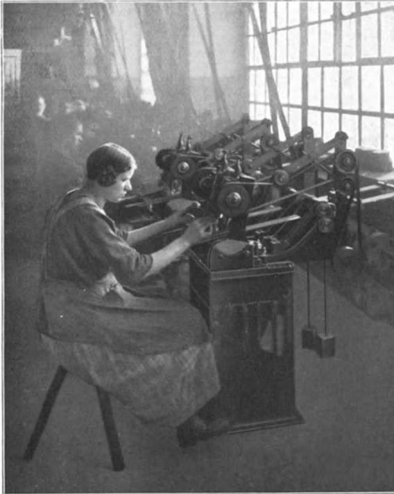
Abb. 257. Das Hauen der Kanten von Sägefeilen.
