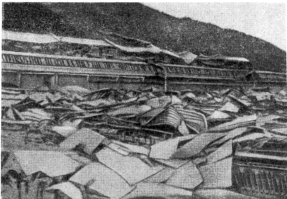
Рис. 263. Японское землетрясение 1 сентября 1923 г. Развалины текстильной фабрики и соседних домов в Токио
