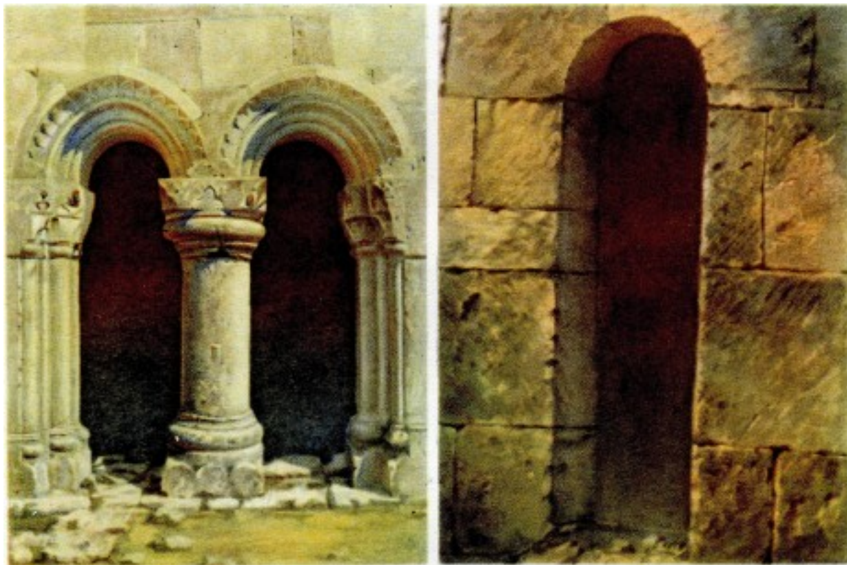
Рис. 88. Фрагменты фасадов из тесаного камня при солнечном освещении. Слева — фрагмент показан при полуденном свете; справа — при вечернем освещении.
