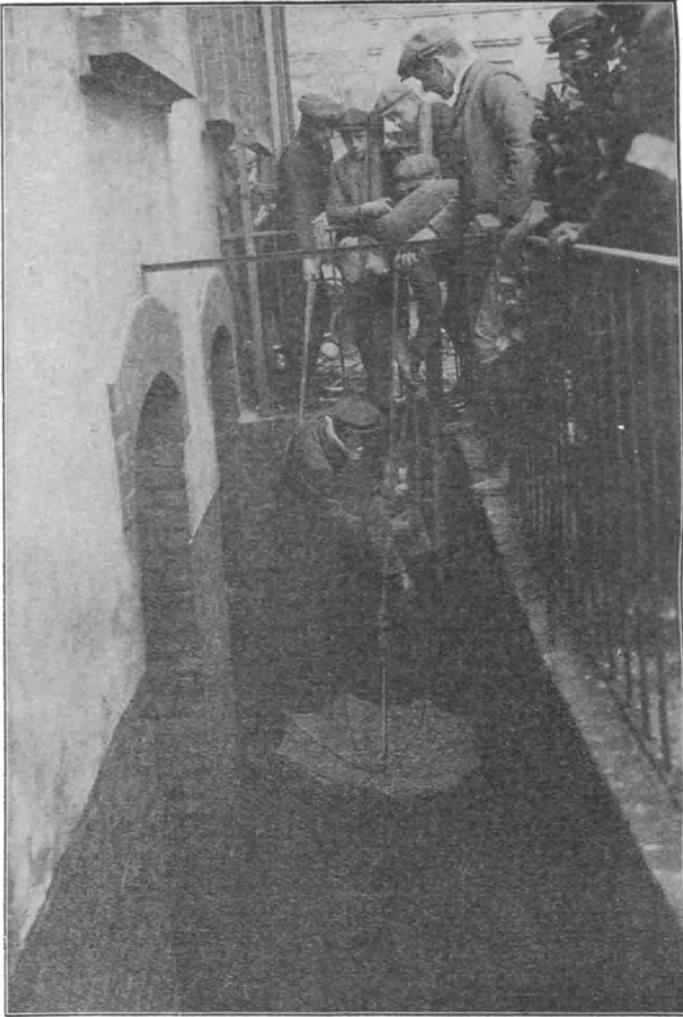
Rettung eines Ersticken aus einer Grube. — Lüftungsschirm nach unten; der Schirm wird vor dem Einsteigen mehrmals auf und ab gezogen, um die schädlichen Gase zu entfernen
