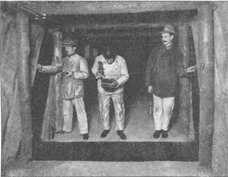
Fig. 164. Bestimmung des Streichens eines querschlägig durchfahrenen Flözes.
