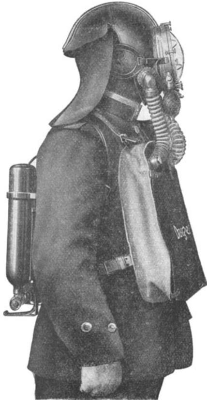
Abb. 341. Ansicht des Dräger-Atmungsgerätes mit Helmatmung.
