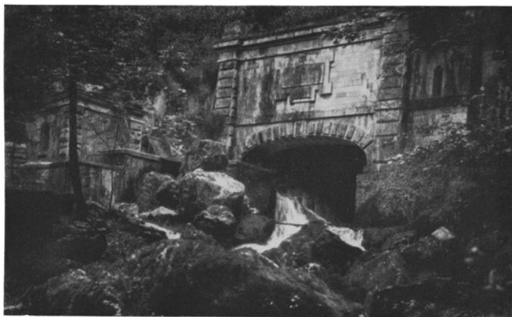
Abb. 139. Fürstenbrunnen am Fuße des Untersberges bei Salzburg. Fassung einer Höhlenquelle. Aufnahme Stiny 1932.
