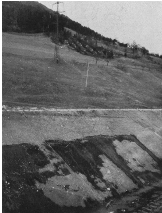
Abb. 39. Wasseraustritte an der Grenze zwischen dem durchlässigeren Gehängschutt und den minder durchlässigen, sandigen Aulehmen. Aushub des Oberwassergrabens der Murkraftwerke bei Laufnitzdorf, Steiermark. Aufnahme Stiny 1931.
