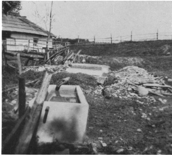
Abb. 138. Mißglückte Quellfassung in Lanzendorf, unweit des Sablatnig-Sees, Jauntal, Kärnten. An der Grenze zwischen Eiszeitschottern und Moräne trat Wasser aus. Die Nachgrabung erfolgte unfachgemäß (zu wenig tief); in Trockenzeiten rinnt daher aus der Brunnenstube (rückwärts neben dem Aushubhaufen) kein Wasser in den Viehtränktrog (vorne) ab. Die Niederstspende rieselt ungenutzt zwischen Sammelstube und Erdhaufen heraus.
