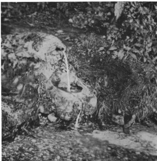
Abb. 125. Einfache Fassung einer Spaltquelle aus Sattnitzkonglomerat. Herminenquelle am Klopeinersee, Kärnten. Aufnahme Stiny 1932.
