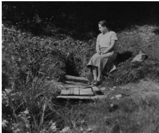
Abb. 145. Quelltopf bei St. Kanzian im Jauntale (Kärnten), zu einem einfachen, offenen Schöpfbrunnen umgestaltet. Hohe Gefahr der Verunreinigung des Wassers.
