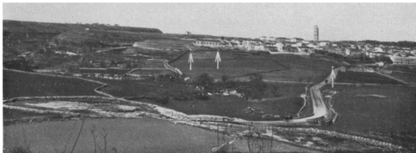
Abb. 50. Thiesi in Sardinien von Osten her (Aufnahme S t i n y 1929). Die mit den zwei Pfeilen links bezeichneten Quellen führen Wasser aus der Algenkalkbank, welche die Stadt trägt (Steilabstürze links); oberhalb der Quellen der Friedhof (D). Weniger der Verunreinigung ausgesetzt ist die Quelle beim Pfeil rechts, welche von der Hangenkalkbank durch eine Mergellage getrennt wird.
