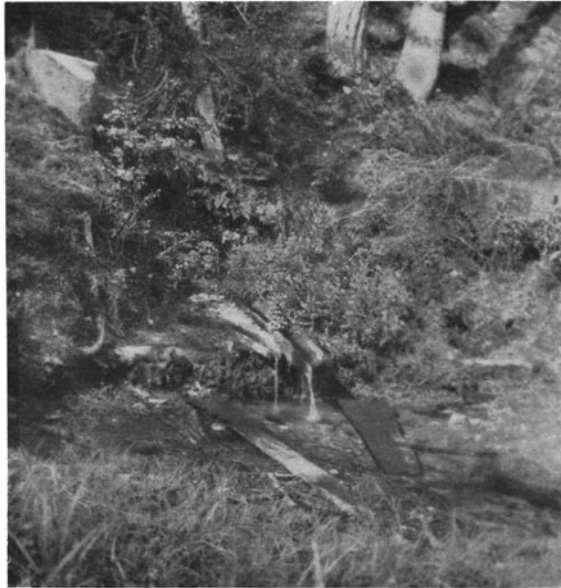
Abb. 126. Einfachste Fassung einer Grenzquelle mittels Holzrinnen. Talung bei Rotschitschach, Jauntal, Kärnten. Aufnahme Stiny 1932.
