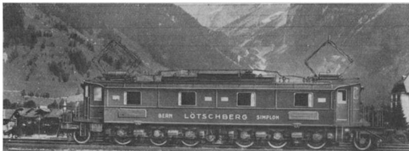
Abb. 429. 1 C<sub>0</sub>—C<sub>0</sub> 1-Schnellzuglokomotive Reihe 201 der Berner Alpenbahngesellschaft Bern-Lötschberg-Simplon.
