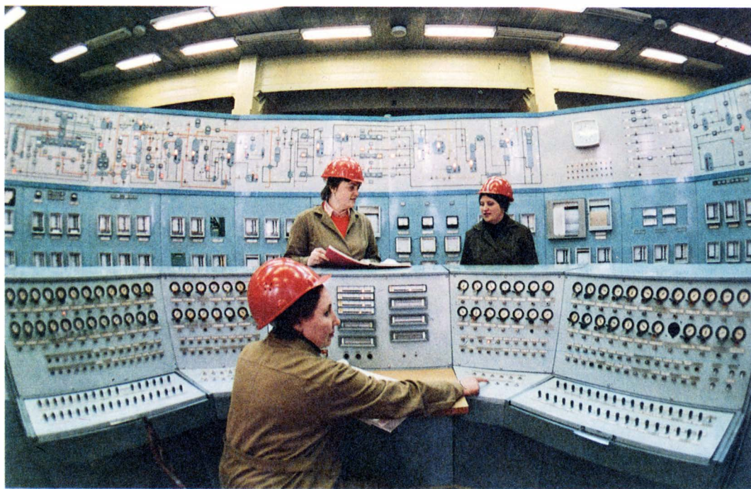
Пульт управления завода минеральных удобрений.
