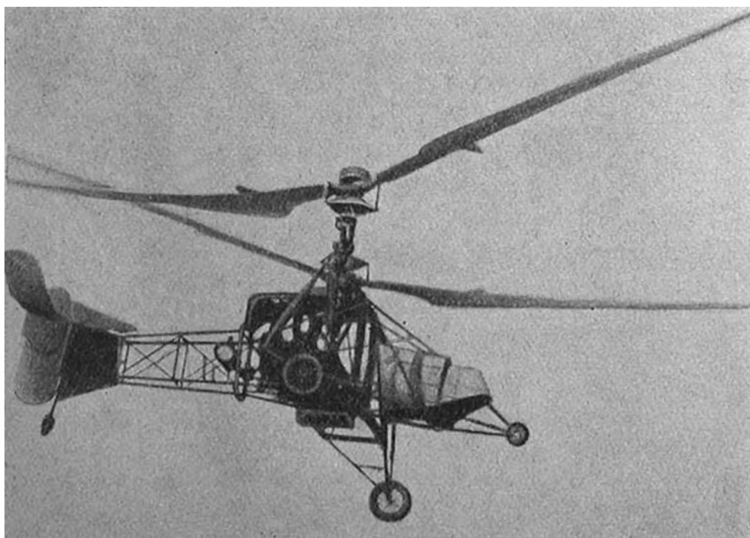
Фиг. 76. Жироплан Бреге-Доран с шарнирными плоскими лопастями и втулкой с поводковым механизмом.
