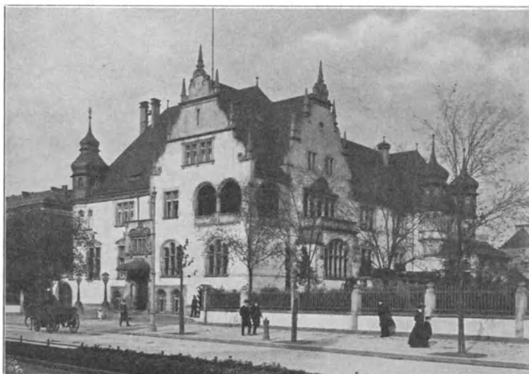
Abb. 167. Wohnhaus des Kommandierenden Generals des Dritten Armee-Korps.
