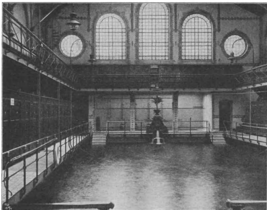
Abb. 139. Die Schwimmhalle der städtischen Volksbadeanstalt.
