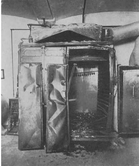
Abb. 5. Zerstörter Lacktrockenofen.
