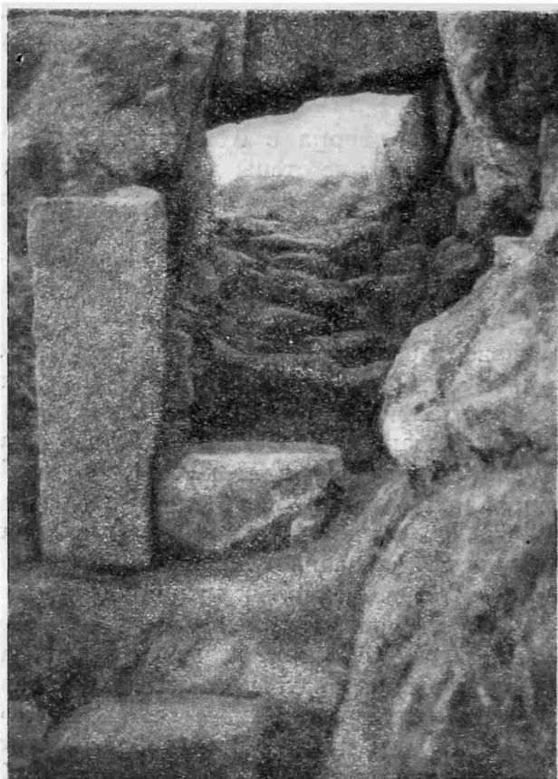
Рис. 37. Херсонес. Лестница со двора в кладовую (помещ. 16)
