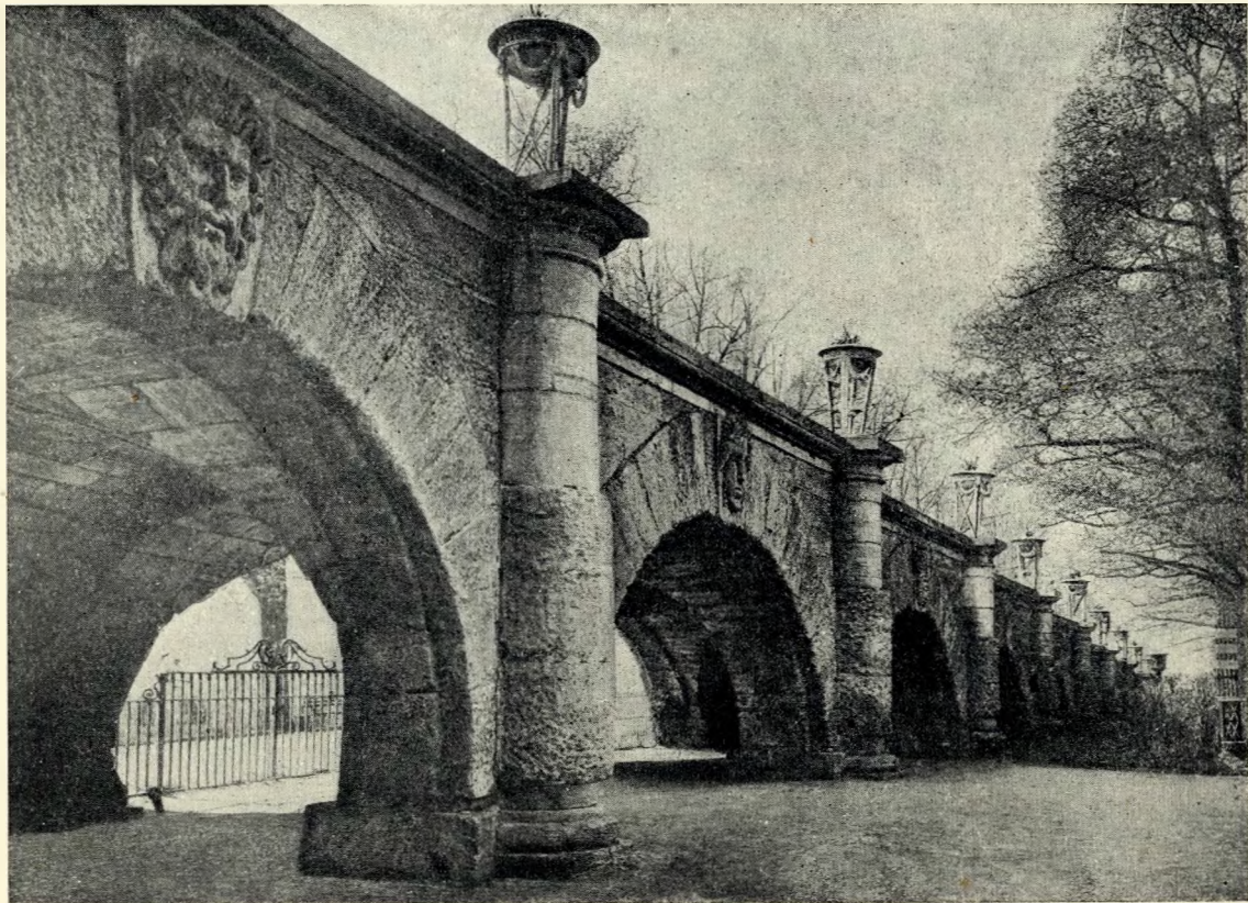
85. Термы Камерона. Пандус. Общий вид аркады с северной стороны
