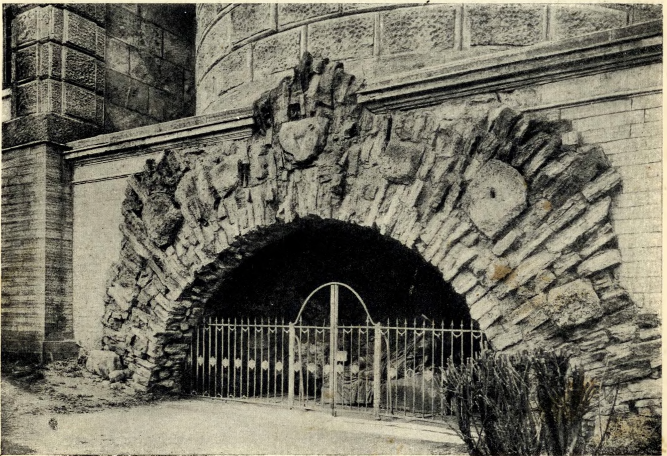
70. Термы Камерона. Грот «Спящей Ариадны» в массиве первого марша лестницы к Большому озеру
