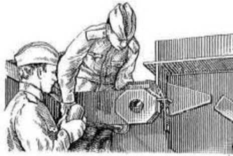
Рис. 68. Установка монтажных тяг (марка 20 или 21)
