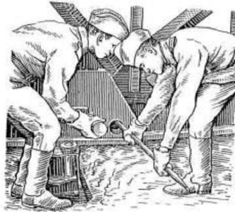
Рис. 63. Совмещение отверстий в проушинах секций для установки штырей главных ферм
