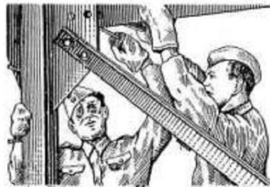
Рис. 54. Установка распорки (марка 36) при укрупнении элементов опор
