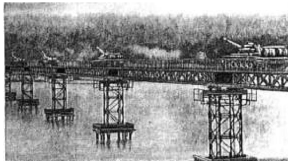
Рис. 1. Общий вид однопутного моста
