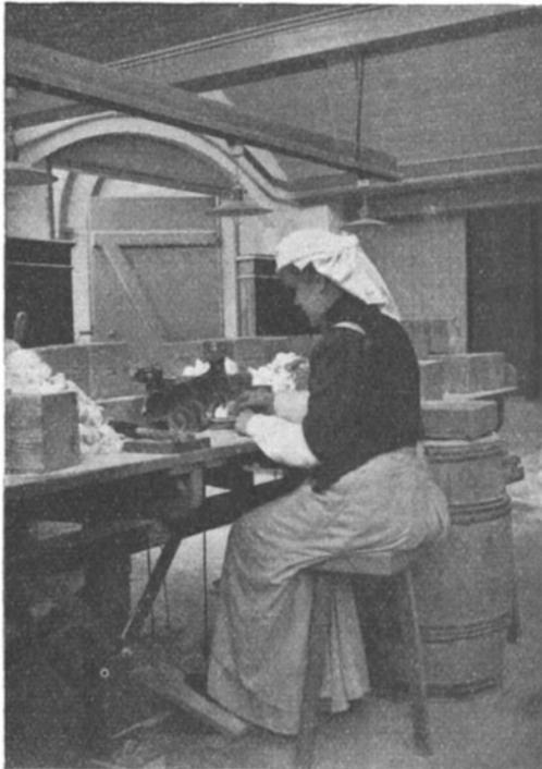
Abb. 6. Abklopfen der Begleitmineralien oder Einsprengungen im Kryolith mittels Hämmerchen und Handsortierung.
