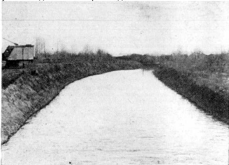
Рис. 80. Инфильтрационный канал на водозаборе из р. Томь
