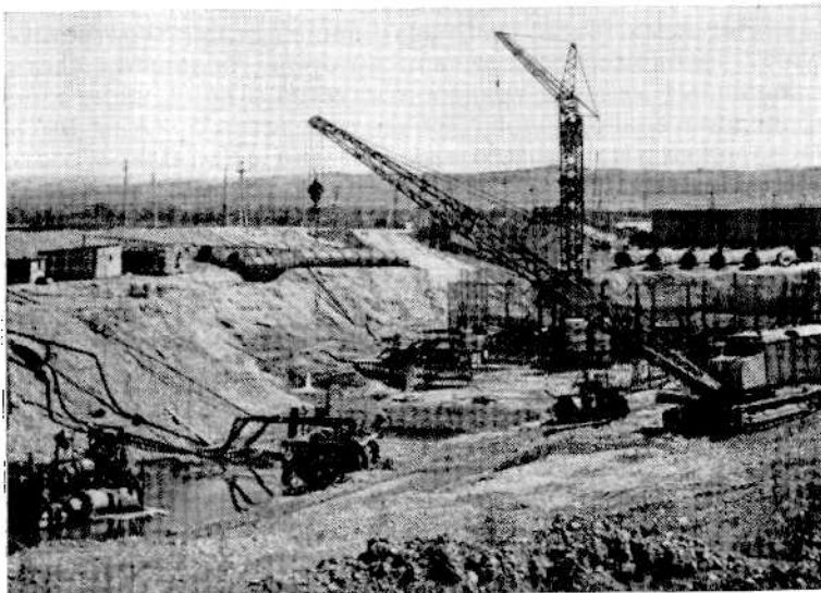
Рис. 6. Строительство ковшового водозабора на р. Томь
