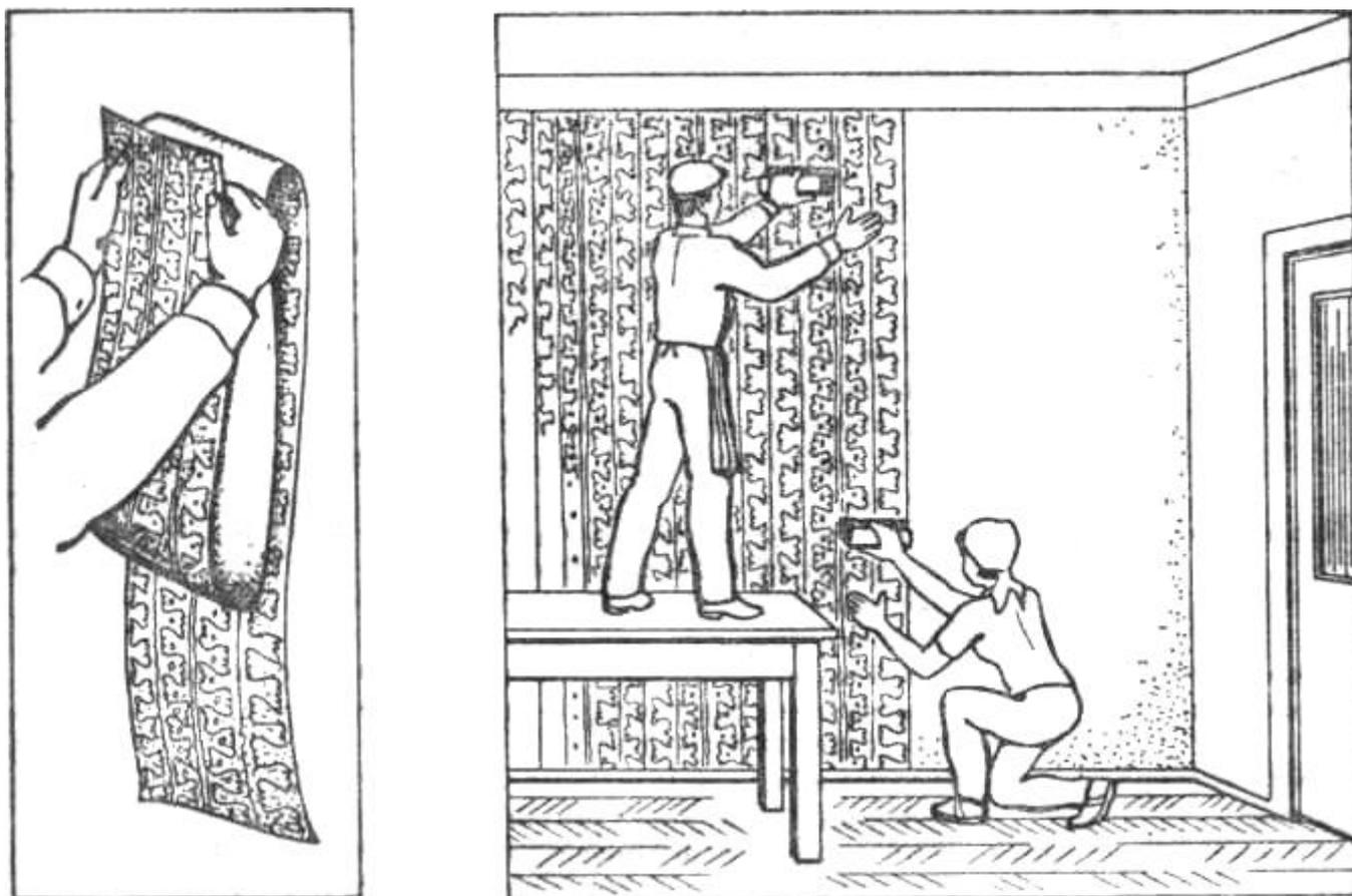
**Рис. 113. Подача и приклеивание полотнища обоев.**
