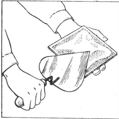
Рис. 117. Накладывание раствора на плитку срезанной пирамидой.
