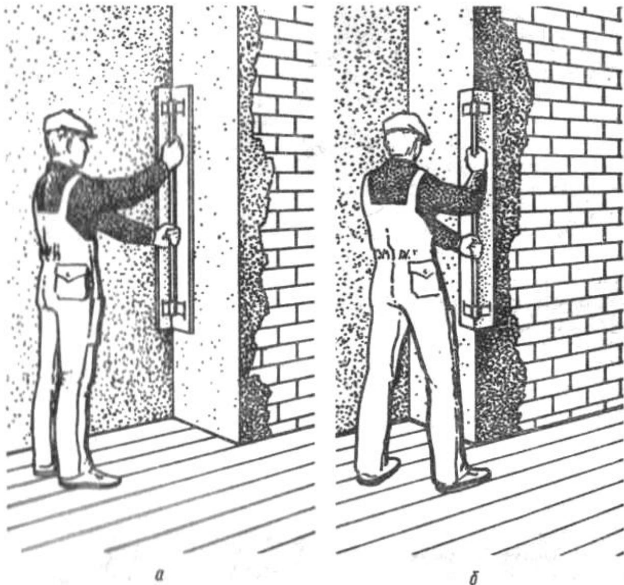
Рис. 69. Натирка лузга (а) и усенка (б) фасонными полуторками.
