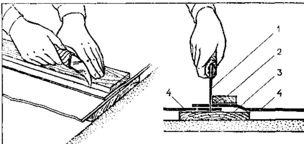
**Рис. 61. Прирезание кромок линолеума:**
