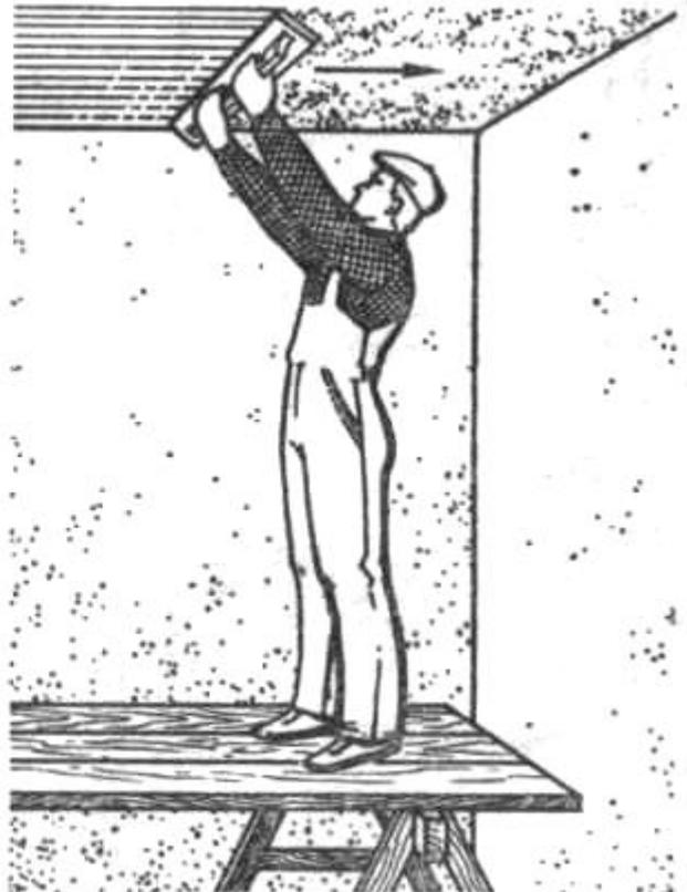
Рис. 67. Разравнивание раствора полутерком:
