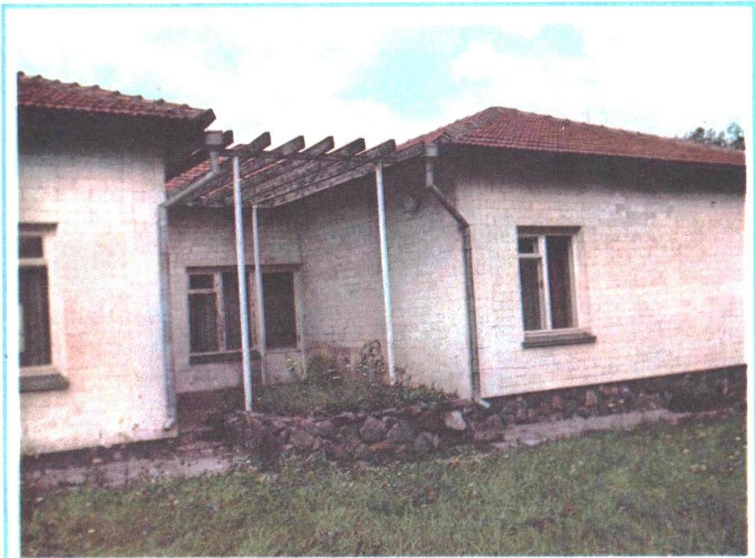
В оформлении фасада использованы облицовка стен известняковой плиткой, черепичная кровля и художественно выполненная кладка цоколя из бутового камня.
