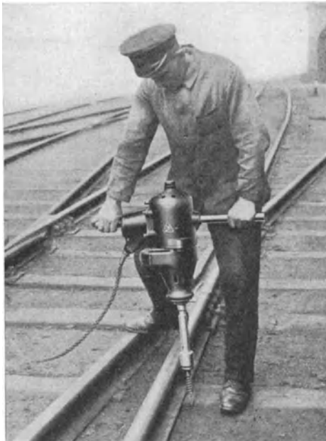
Abb. 160. Elektrische Handbohrmaschine (Krupp, Essen).
