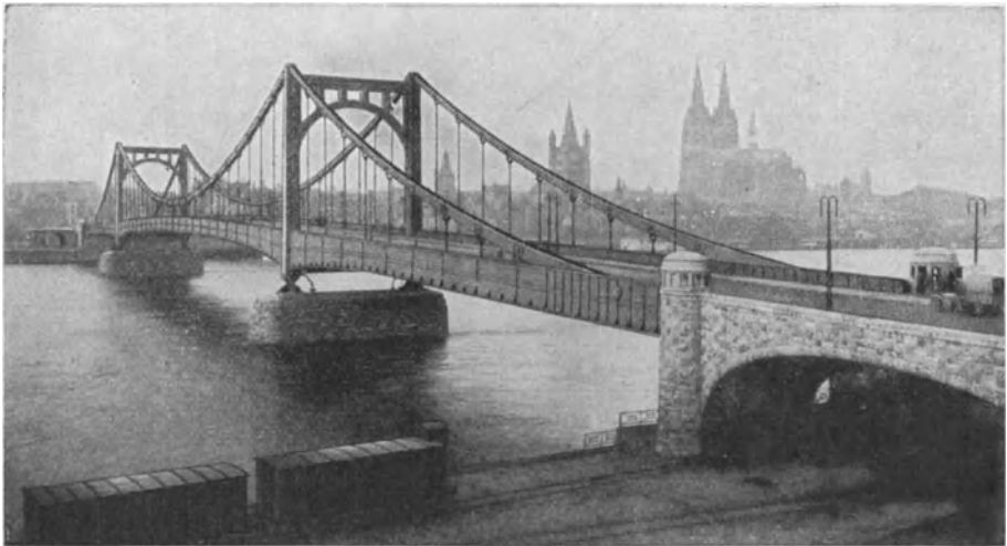
Abb. 162. Hängebrücke über den Rhein bei Köln (erbaut von der Maschinenfabrik Augsburg-Nürnberg). (TWL 1447).
