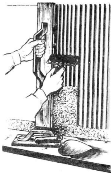
Рис. 128. Обработка штукатурки валиком
