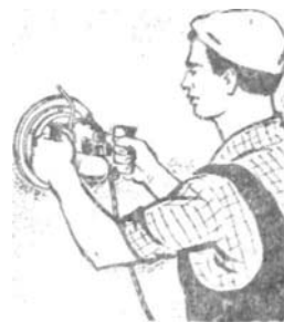
Рис. 43. Затирка штукатурки электрической машинкой
