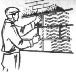
Рис. 61. Установка простых реек для устройства рустов
