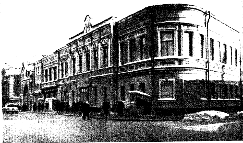
УЛ. ГЕРЦЕНА, ДОМ № 21 (ДОМ КНЯЗЕИ СИБИРСКИХ). ФОТО АВТОРА
