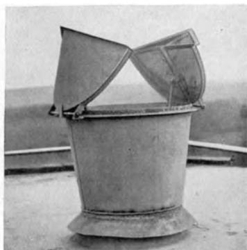
Abb. 39b. Regenschutzkappe, geöffnet
