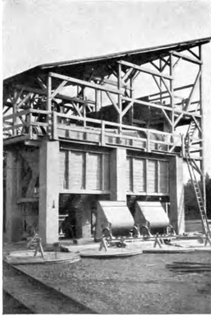
Abb. 2. Schotterwerk in offener Bauweise
