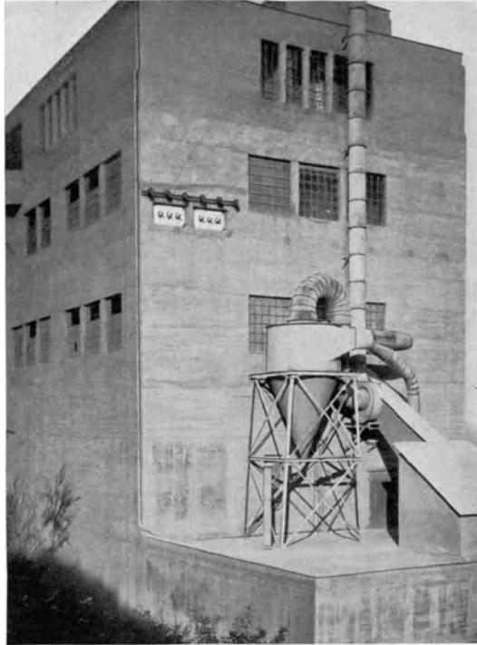
Abb. 47. Entstaubungsanlage der Rhein. Provinzial-Basaltwerke. (Lüfter hinter Abscheider).
