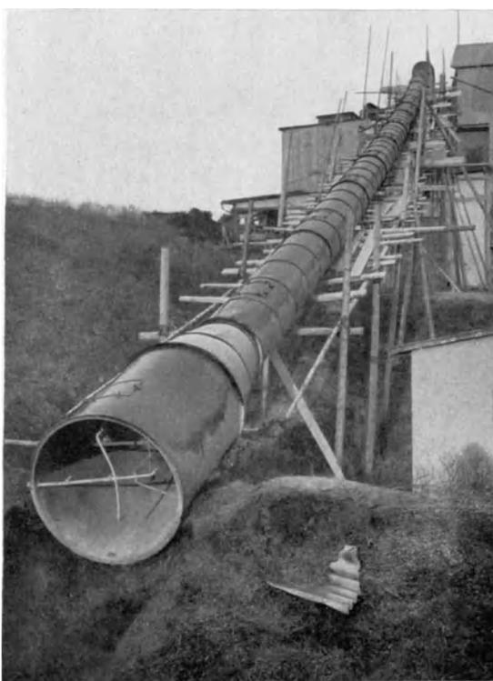
Abb. 40. Staubluft-Naßreinigung (Basaltwerk in Andernach).
