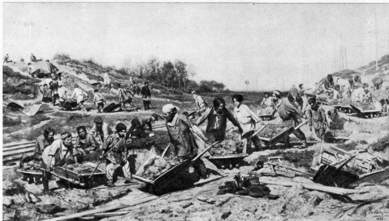
65. К. А. Савицкий. Ремонтные работы на железной дороге. 1874
