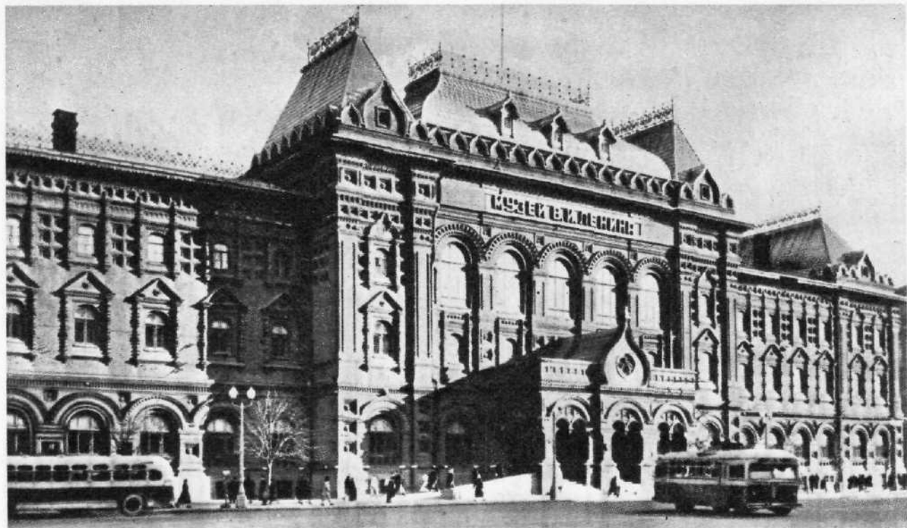
216. Д. Н. Чичагов. Московская Городская дума (ныне Музей В. И. Ленина). 1890—1892. Москва
