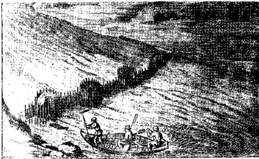
Рис. 97. „Ея“—гидротехническое сооружение для ловли рыбы, широко применявшееся со времен древней Руси.— По гравюре XVIII века.
