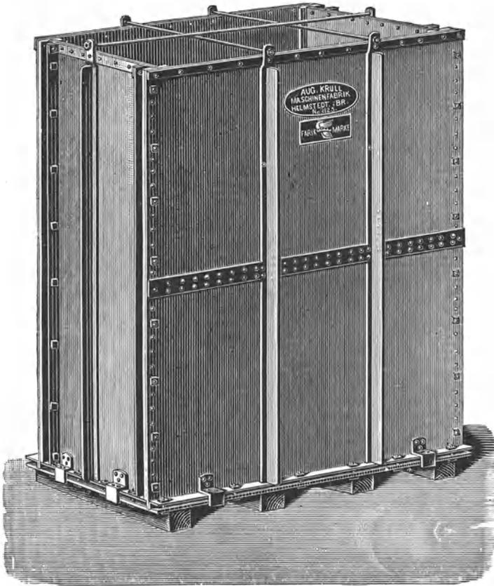
Abb. 36. Seifenform mit Mutterschraubenverschluß.
