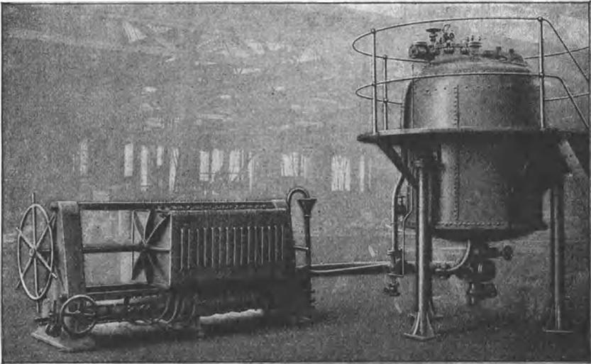
Abb. 100. Seifenplattenkühlmaschine von Heinr. Schrauth.
