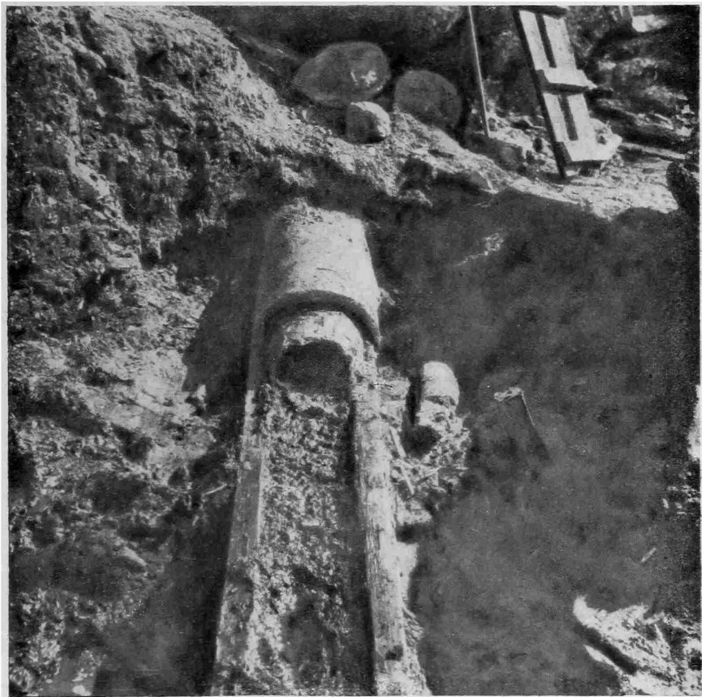
126. Шиповое соединение концов водоотводных труб.
