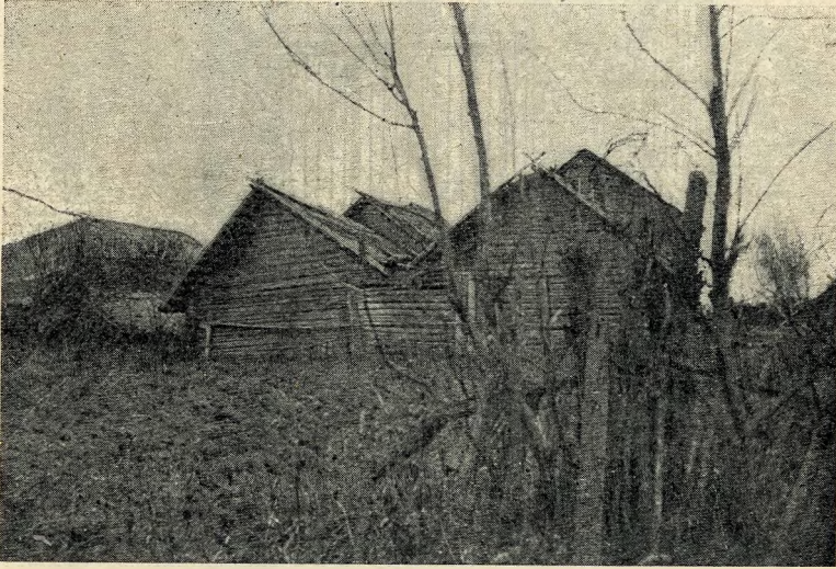
Рис. 49. Задний фасад стройки С. Н. Гусева в с. Слободищеве Тимоновской вол.
