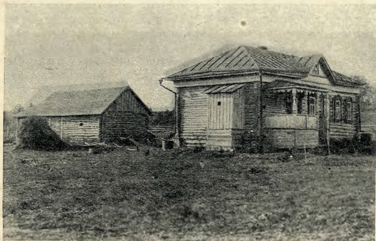
Рис. 62. Общий вид стройки Сквознова в с. Астрецове Яхромской вол. Построено в 1928 г.
