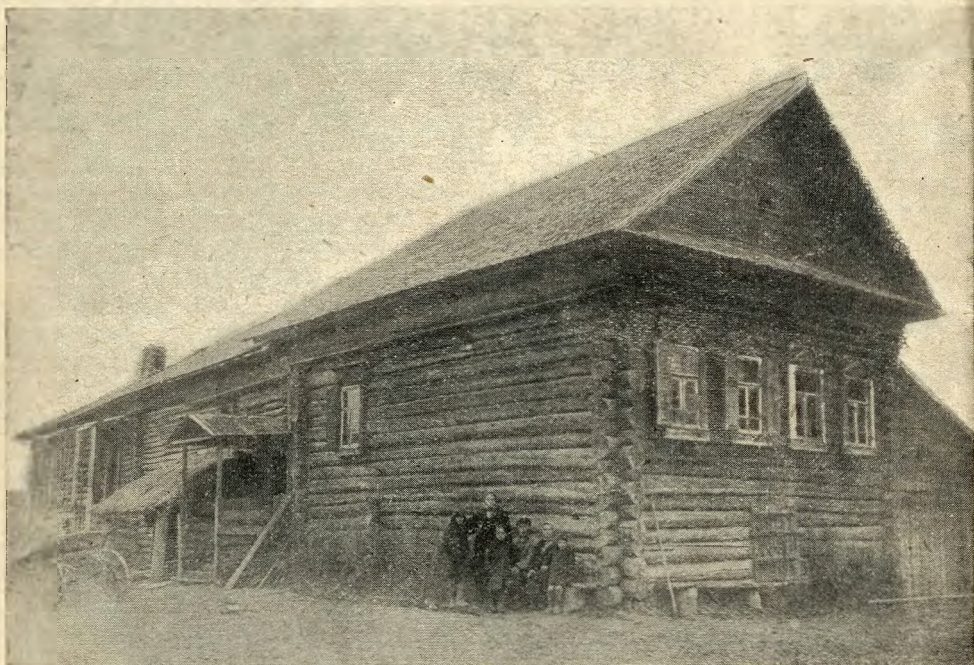
Рис. 14. Изба Ф. Н. Мочалова с. Ковригино Тимоновской вол. Изба летняя 8,52 \times 7,1 м.—(12 \times 10 арш.). Зимняя 5,68 \times 5,68 м. (8 \times 8 арш.), а прежде зимняк был 6,39 \times 7,1 м. (9 \times 10 арш.).
