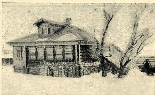
Рис. 25. Запележенная зимняя изба (полуподвальный этаж) в д. Настасьине.
