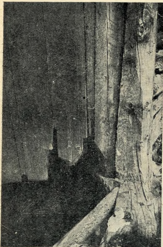
Рис. 28. Ворота с деревянной пятой в с. Жестылеве.
