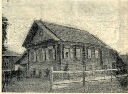
Рис. 15. Изба в с. Ильине Тимоновской вол. Вход в подызбицу с боковой стороны.
