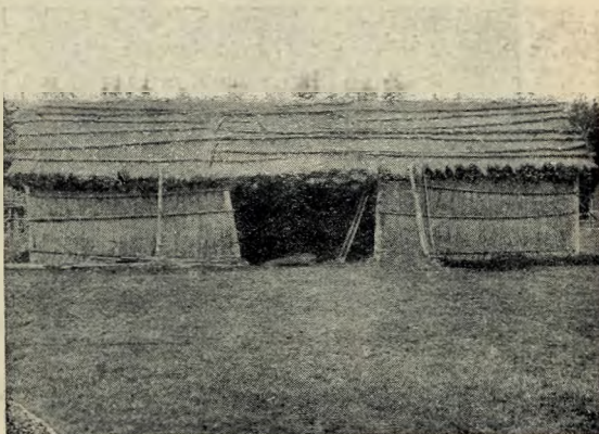
Рис. 119. Сенной сарай со стенками из соломенных рамок в с. Языкове Обольяновской вол.
