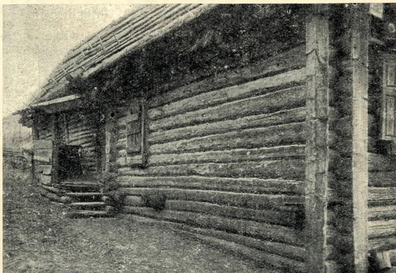
Рис 29. Боковая стена избы крест. Гвоздева в с. Жестылеве: на стене видны выходящие наружу переводы.
