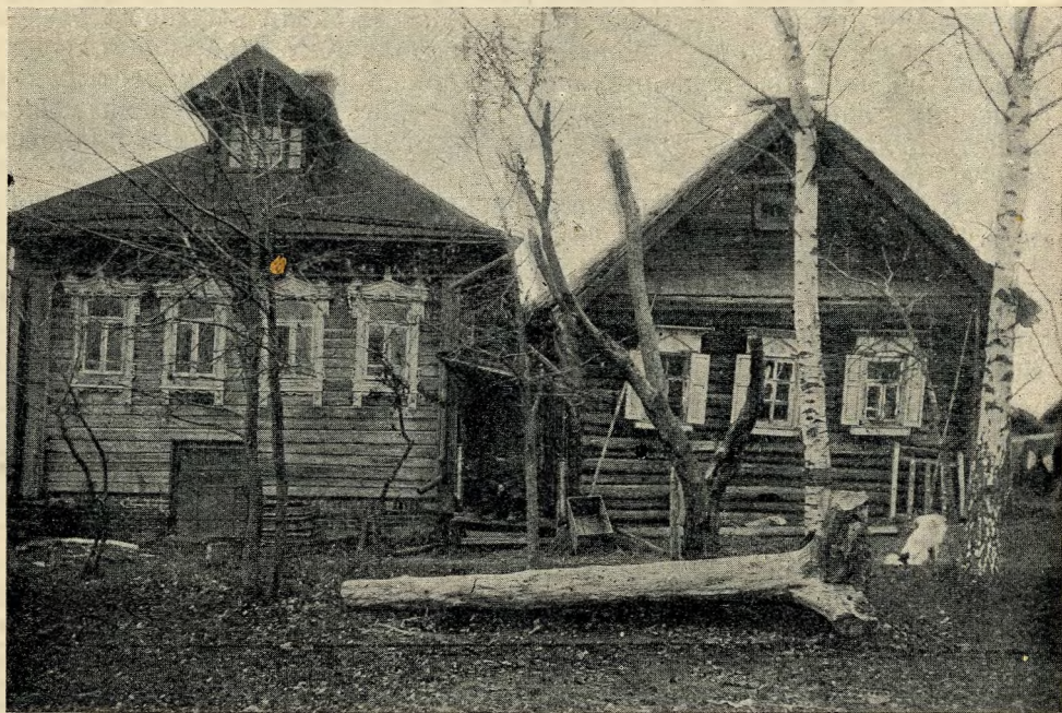
Рис. 48. Передний фасад стройки Гусева с. Слободищево Тимоновской вол.
