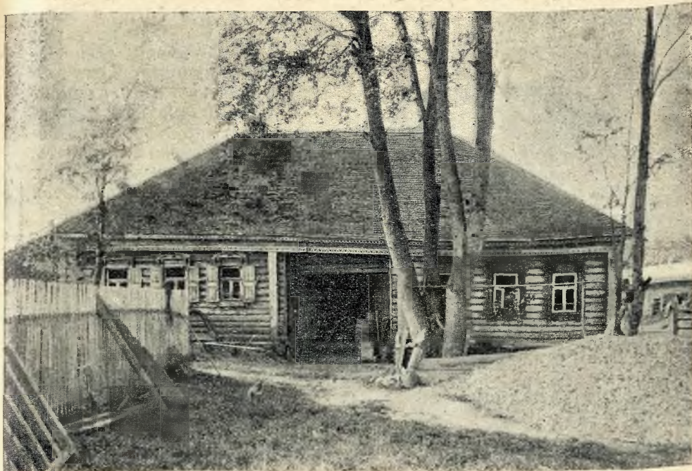
Рис. 78. Передний фасад стройки И. И. Голунина.
