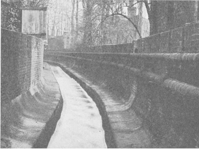
Abb. 88. Dampfheizwerk Barmen. Im Mühlgrabenbett verlegte Dampffernleitung.
