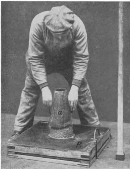
Abb. 149. Setzprobe. Heben der Form *a*.
