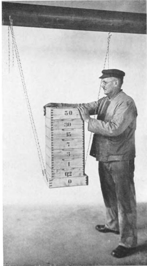
Abb. 131. Siebsatz zur Feststellung der Kornzusammensetzung von Sand, Kies usw. (Modell Stuttgart 1929.)
