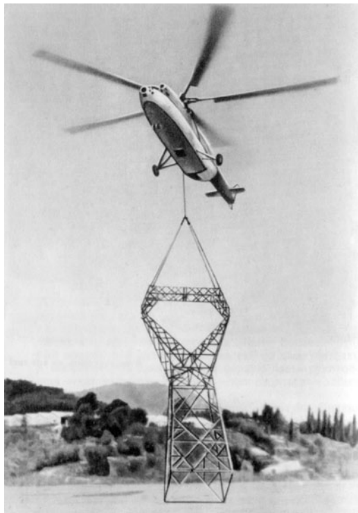
Ми-6 транспортирует ферму ЛЭП
