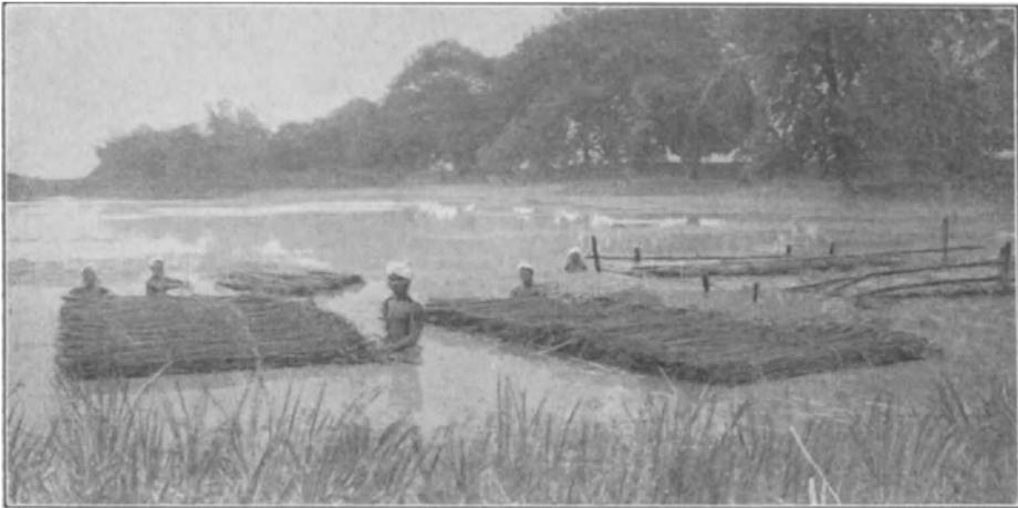
Abb. 22. Einlegen der Jutebündel in das Wasser zwecks Rösten.
