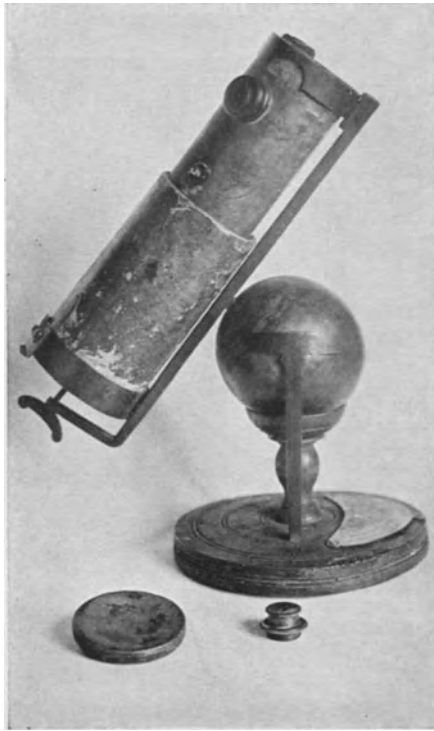
A. Die alte Inschrift auf dem Sockel lautet: Das erste reflektierende Fernrohr, erfunden von Sir Isaac Newton und mit eigenen Händen von ihm angefertigt im Jahre 1671. (Mit Genehmigung des Vorstandes der Royal Society.) Höhe etwa 45 cm. (S. 84.)
