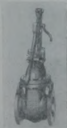
Рис. 36. Быстрооткрывающаяся задвижка (по материалам CraneCo)
