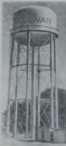
Рис. 74. Резервуар с эллипсоидальным днищем Сулливан, штат Иллинойс (по материалам Chicago Bridge and Iron Co.)
