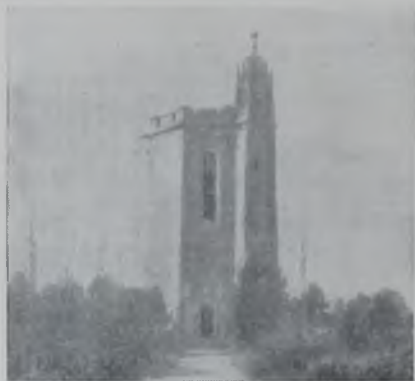
Рис. 79. Водонапорная башня на Гейтоф Хевн Семетри. Запроектирована Чарльзом Уэлфордом Ливиттом и его сыном (по материалам Chicago Bridge and Iron Co.)
