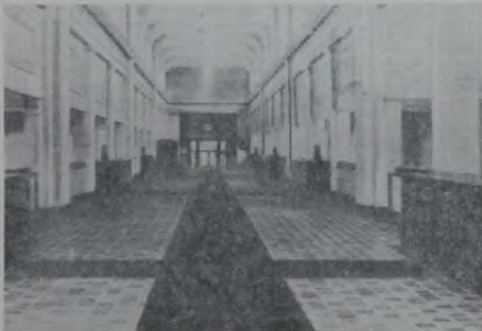
Рис. 108. Рабочий зал фильтровальной установки Дес Мойнес, шт. Айова (по материалам Dale L. Maffitt and V. R. Kreier)
