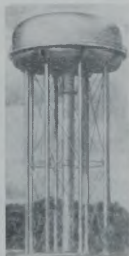
Рис. 75. Резервуар с радиально-коническим днищем в Форт Лаудердейл, штат Флорида (по материалам Chicago Bridge and Iron Co.)
