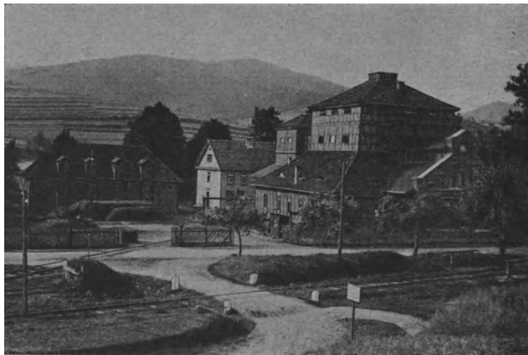
Abb. 1. Hochofen „Neue Hütte“ (Happelshütte).
