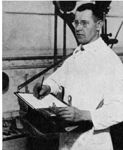
Abb. 12. Diagnostiker, tragbar, mit 5 Schreibstiften und Schreibplatte.
