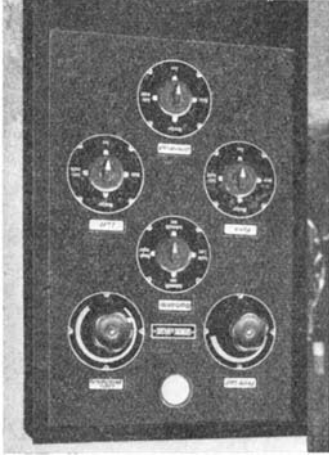
Abb. 36a. Bedienungstafel für die selbsttätige Siemens-Kesselregelung. Die Schalter gestatten, die Automatik ganz oder teilweise auf Handbedienung umzustellen. Ferner ist mit ihnen die Einstellung auf feste Last möglich, wobei diese feste Last beliebig gewählt werden kann.
