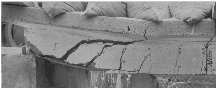
Abb. 2. Bruch am Auflager bei fehlender Schubsicherung.
