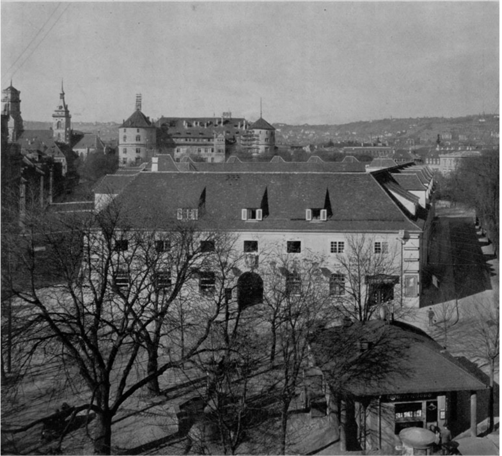
Abb. 2. Haus des Deutschtums in Stuttgart, erbaut 1924. Architekt Paul Schmitthenner. Ansicht des Baues vom Charlottenplatz.
