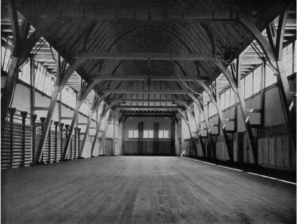
Abb. 6. Turnhalle in Aalen, erbaut 1928. Architekt Bonatz & Scholer. Offene Holzkonstruktion, sichtbar bis in die oberste Dachspitze, rhythmischer Wechsel der Überschneidungen. Die reine Konstruktion ist das entscheidende Gestaltungsmerkmal des Raumes.
