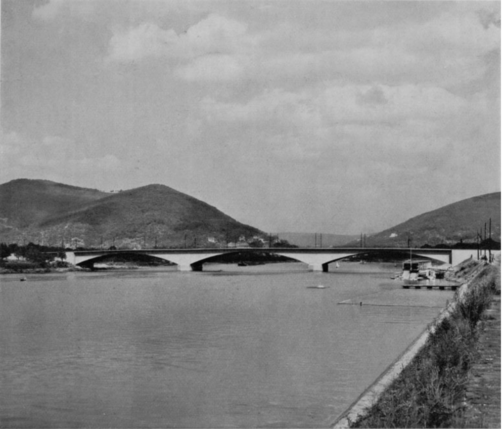
Abb. 7. Betonbrücke in Heidelberg, erbaut 1927. Konstruktion und Ausführung Wayss u. Freytag, Mitarbeiter als Architekt Prof. P. Bonatz.
