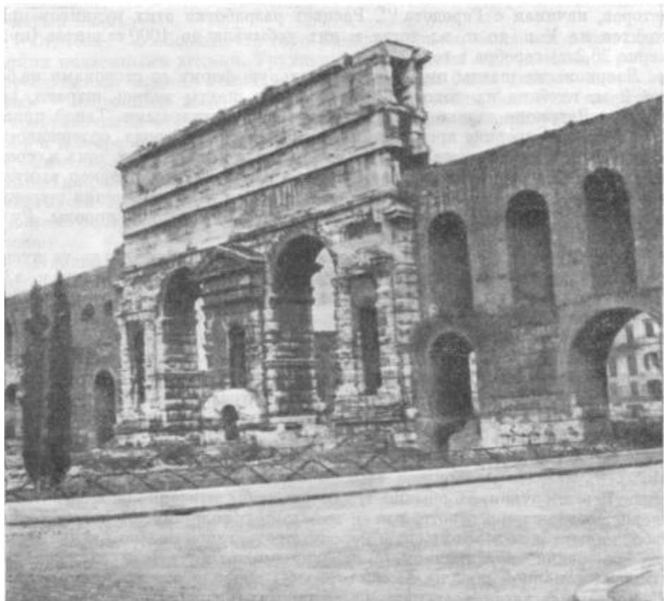
*Парадные ворота (Porta Maggiore), устроенные в Риме на месте пересечения акведука Клавдия с двумя улицами. Немного позднее над первым акведуком был сооружен второй — Новый Аниен. Прилегающие к воротам верхние части акведуков не уцелели, поэтому можно отчетливо видеть каналы обоих водопроводов*
